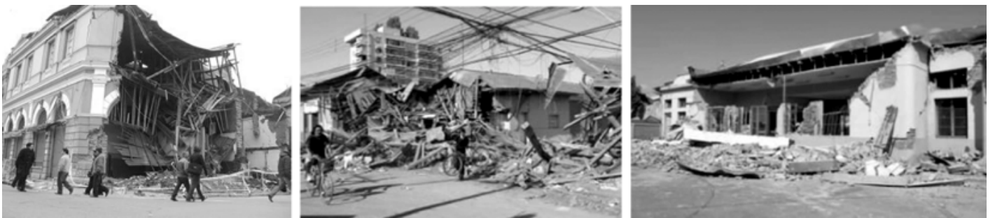
IMG 9: Fotos Curicó post-terremoto. Fuente: Prensa, Curicó
