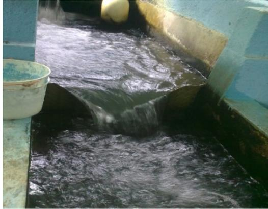
**Figura 5.14. Vertedero triangular del desarenador principal**
