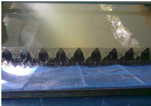
**Figura 5.15. Vertedero posterior del desarenador.**
