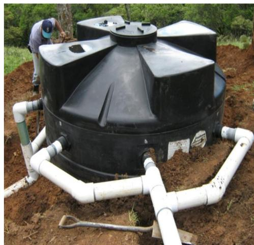
Figura 5.10. Tanque de reunión de las quebradas Q3 y Q4
