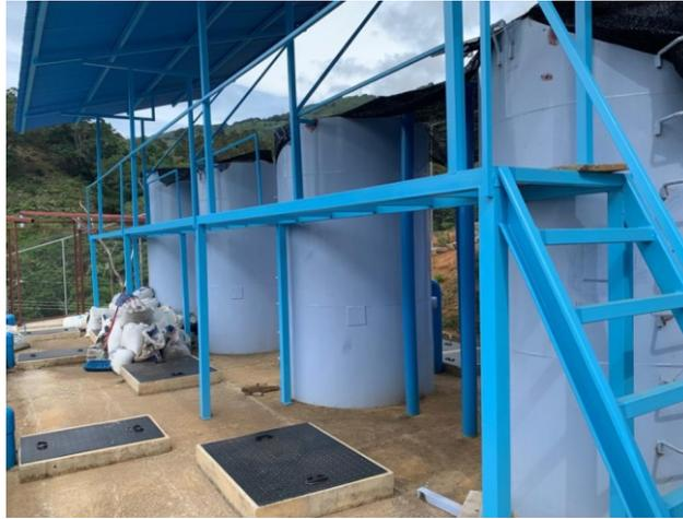
**Figura 5.20. Filtros de la PTAP de la ASADA de Higuito.**
