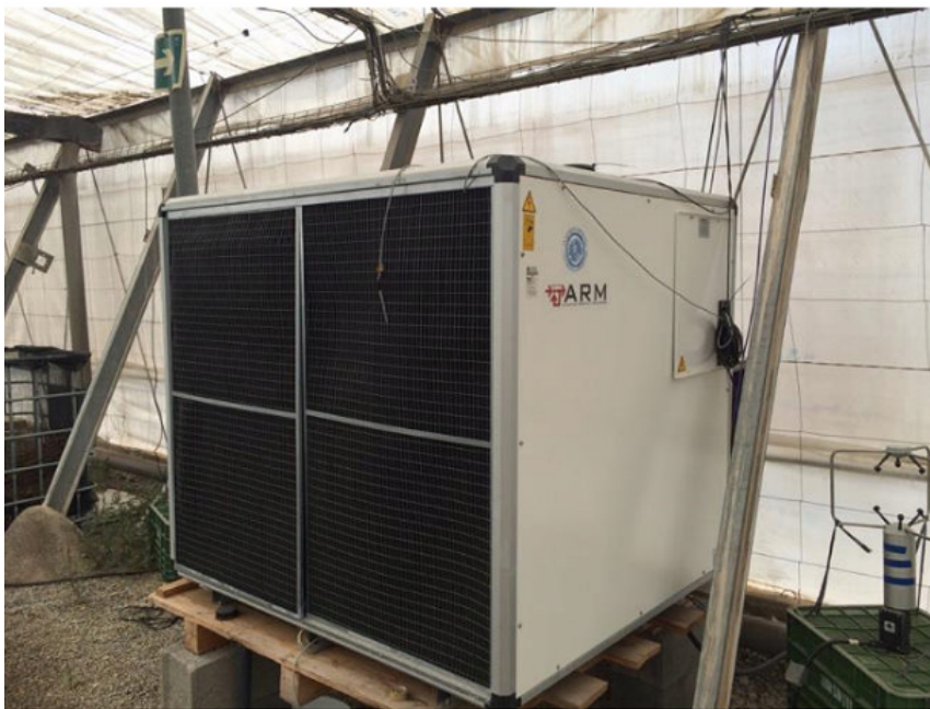
Fig. 2.7. Máquina deshumidificadora de la Nave 7 de la Estación Experimental de la Fundación Cajamar “Las Palmerillas” [11]
