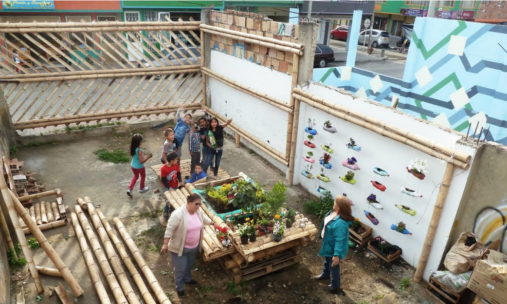
Construcción del espacio cubierto (salón comunal)
