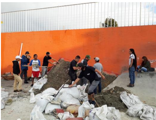
(Construcción DIY barrio el japon súcubo skateparks)
