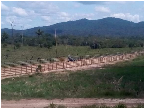
Fotografía 10. Manga de Coleo La Caprichosa en construcción. Cortesía Nelcy Urrego.
