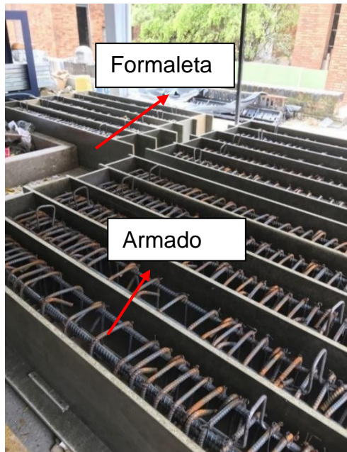
Figura 36. Armado de formaleta y acero de refuerzo.
