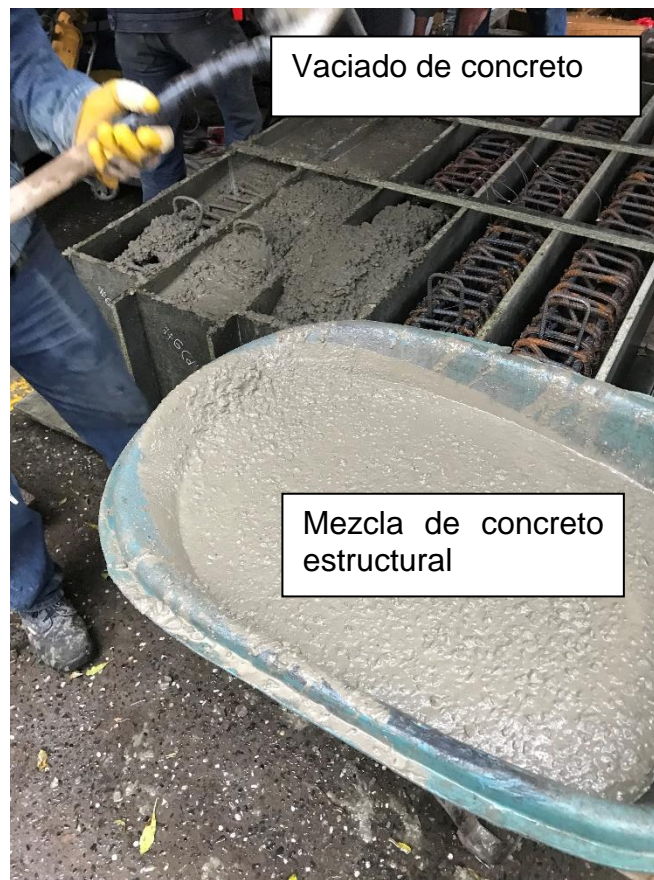
Figura 38. Proceso de vaciado de concreto de probetas tipo viga.
