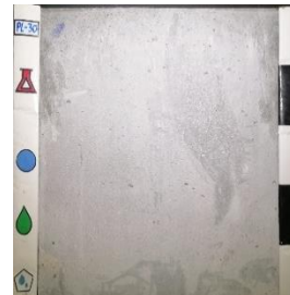
Superplastificante: SP2 Curado: Agua (WC) Desmoldante: Petrodisel (D)
