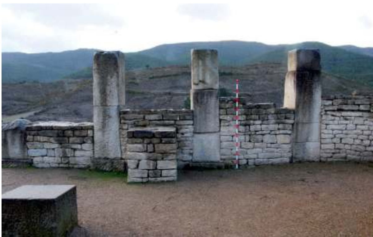
Figura 16. Estado en el que quedó el muro GEM 4 tras la reforma, visto desde el interior del criptopórtico (imagen: R. Cebrián).
