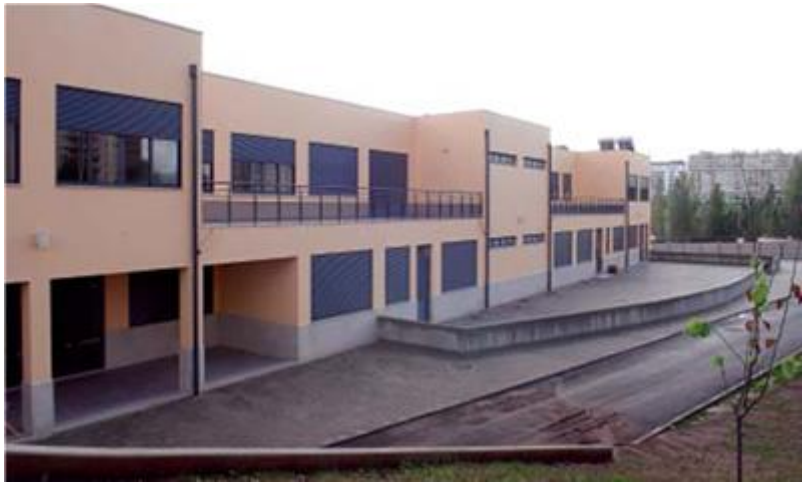
Figura 5 – Fachada da Escola Básica de 2º e 3º ciclos de João Villaret.
