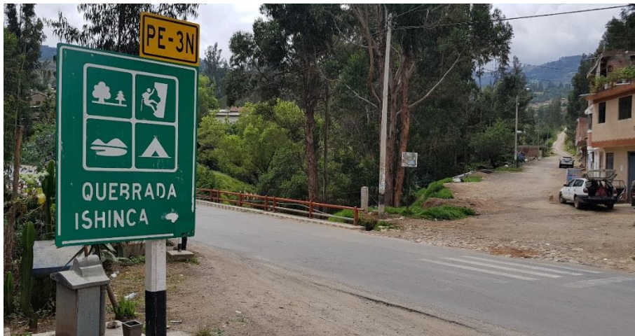
Figura 53 Puente Ishinca Fuente: Archivo personal, fecha de toma 24 de abril de 2019
