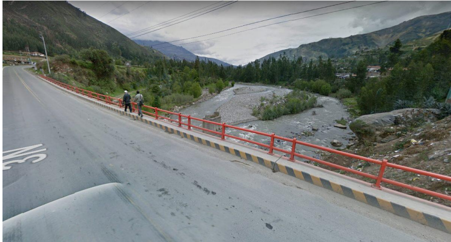
Figura 52 Puente Jangas Fuente: Google Earth Pro, fecha de toma: noviembre de 2013
