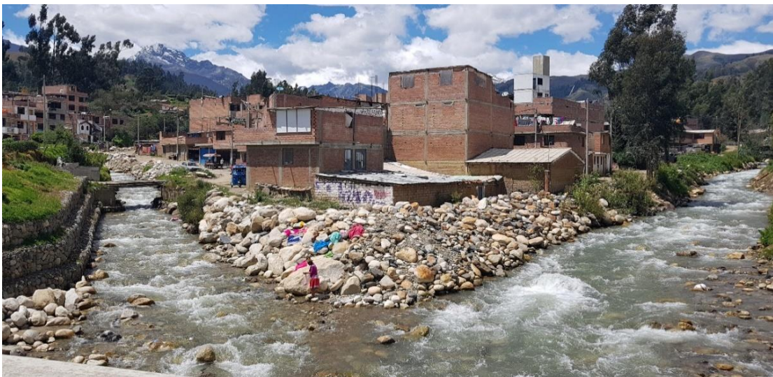
Figura 3 Viviendas con medidas de mitigación (enrocado) en el cono aluvial. Fuente. Archivo personal, fecha de toma: 25 abril de 2019
