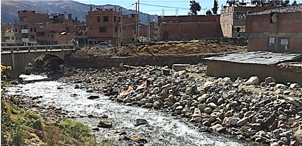
Figura 7 Limpieza de cauce en la confluencia de ríos Auqui y Paria, en el cono aluvial. Fuente. Archivo personal, fecha de toma: 25 abril de 2019
