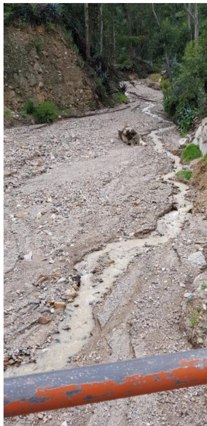
Figura 55 Puente Km 590 / Fuente: Archivo personal, fecha de toma 24 de abril de 2019
