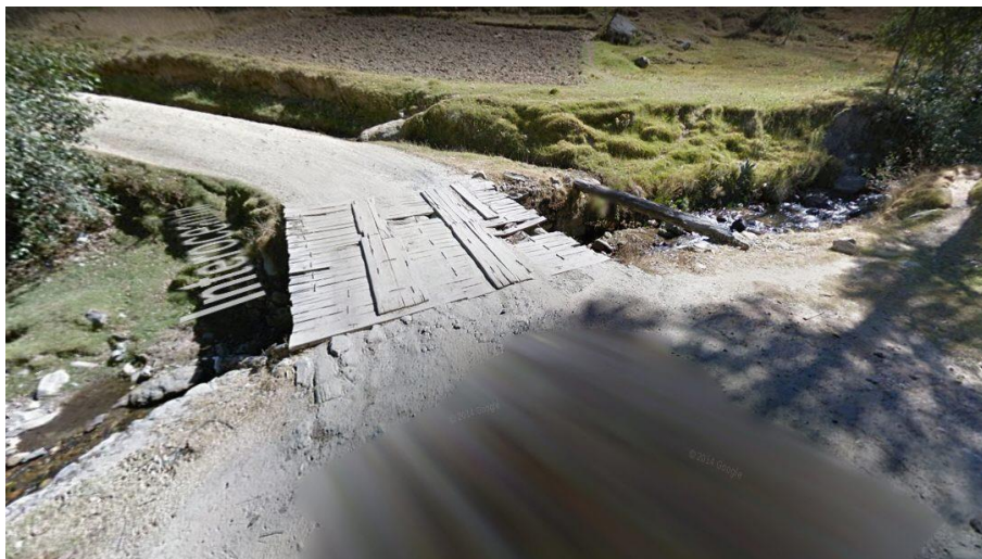
Figura 59 Puente Llupa Fuente: Google Earth Pro, fecha de toma: junio de 2013
