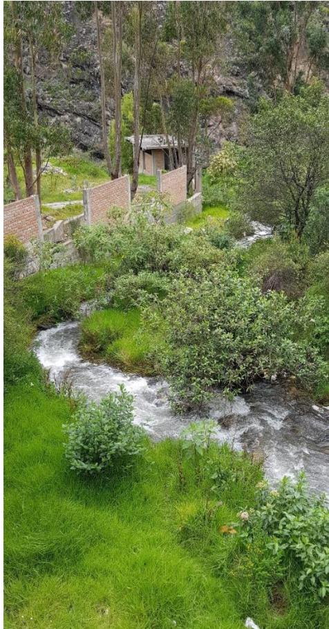
Figura 58 Puente Km 585 Fuente: Archivo personal, fecha de toma 24 de abril de 2019
