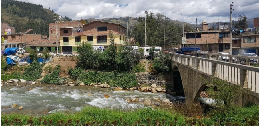
Figura 49 Puente Jr. José Olaya sobre el Río Quillcay Fuente: Archivo personal, fecha de toma: 25 de abril de 2019
