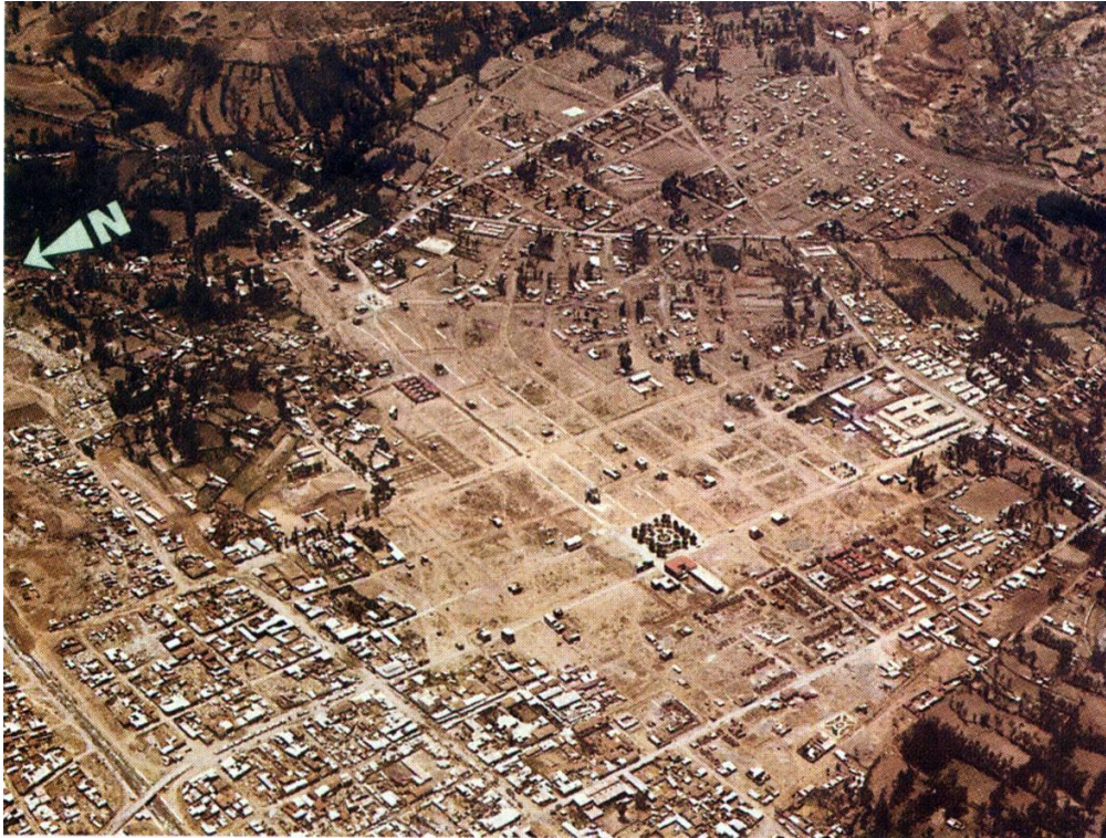
Figura 12 Ciudad de Huaraz después de limpieza de viviendas destruidas, previas a la reconstrucción. Fuente: Asociación Waras, Ciencia y Cultura
