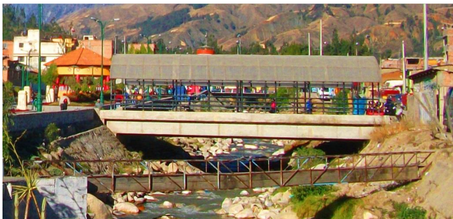
Figura 46 Puente Comercio sobre el río Quillcay Fuente: Archivo personal, fecha de toma: 25 de abril de 2019
