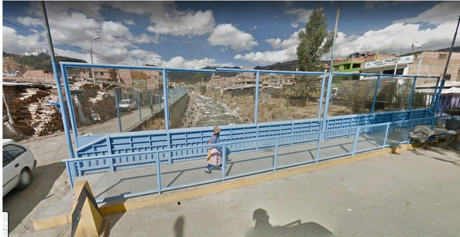
Figura 44 Puente Huascarán sobre río Quillcay Fuente: Google Earth Pro, fecha de toma: julio de 2013
