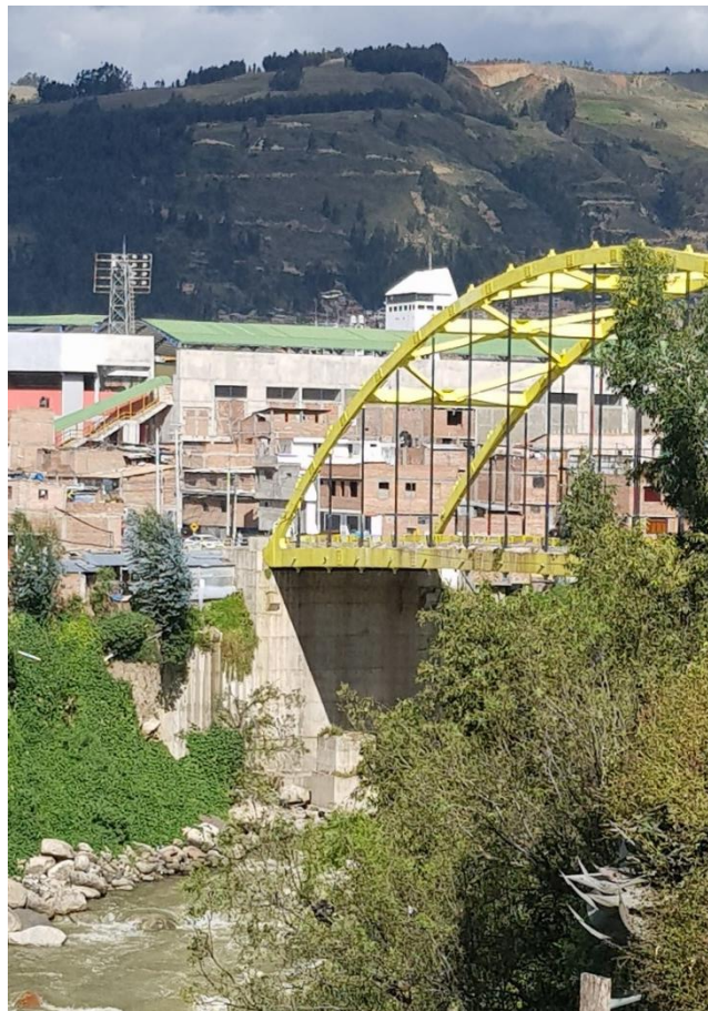
Figura 43 Puente Antonio Raimondi sobre río Santa Fuente: Archivo personal, fecha de toma: 25 abril de 2019
