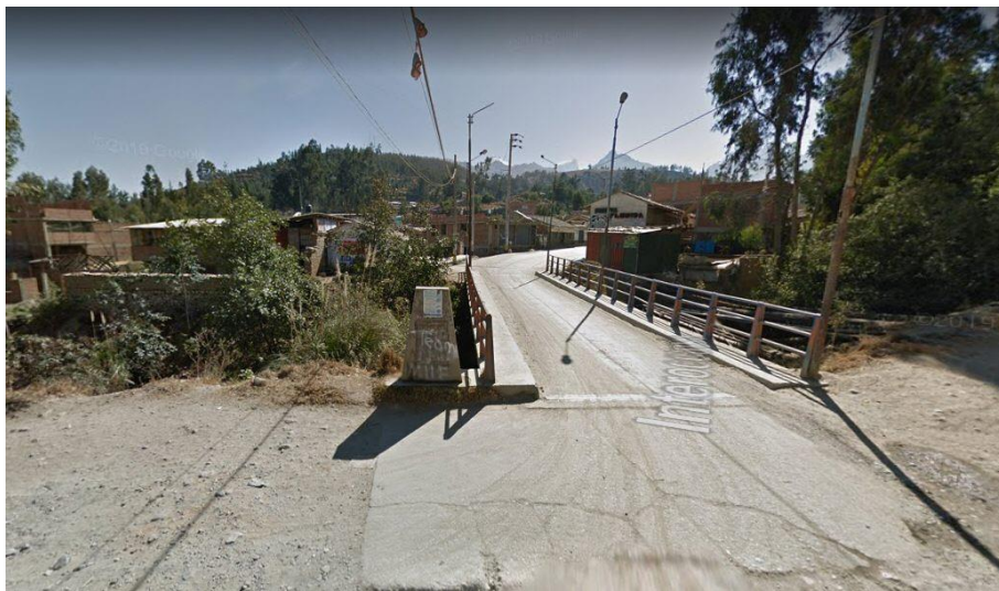
Figura 41 Puente Nueva Florida, sobre río Auqui (Km 1.709) Fuente: Google Earth Pro, fecha de toma: julio de 2013
