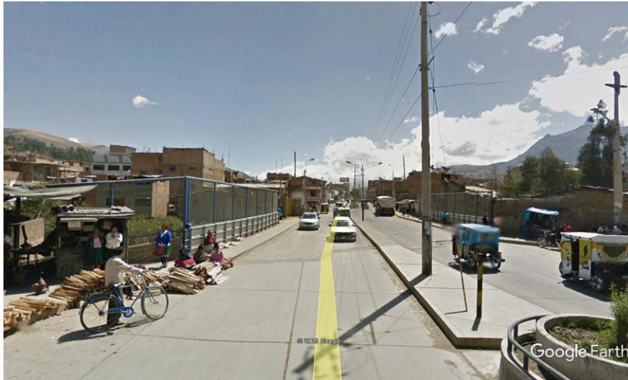
Figura 40 Puente Bolívar, sobre el río Quillcay (Av. Confraternidad Internacional Oeste) Fuente: Google Earth Pro, fecha de toma: noviembre de 2013
