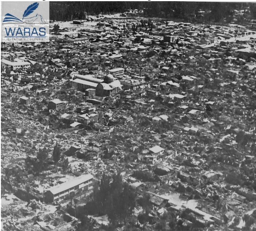
Figura 11 Vista de la ciudad de Huaraz en escombros (1970). Fotografo: Corporación Peruana del Santa. Archivo: Giber G. Alamo Fuente: Asociación Waras, Ciencia y Cultura
