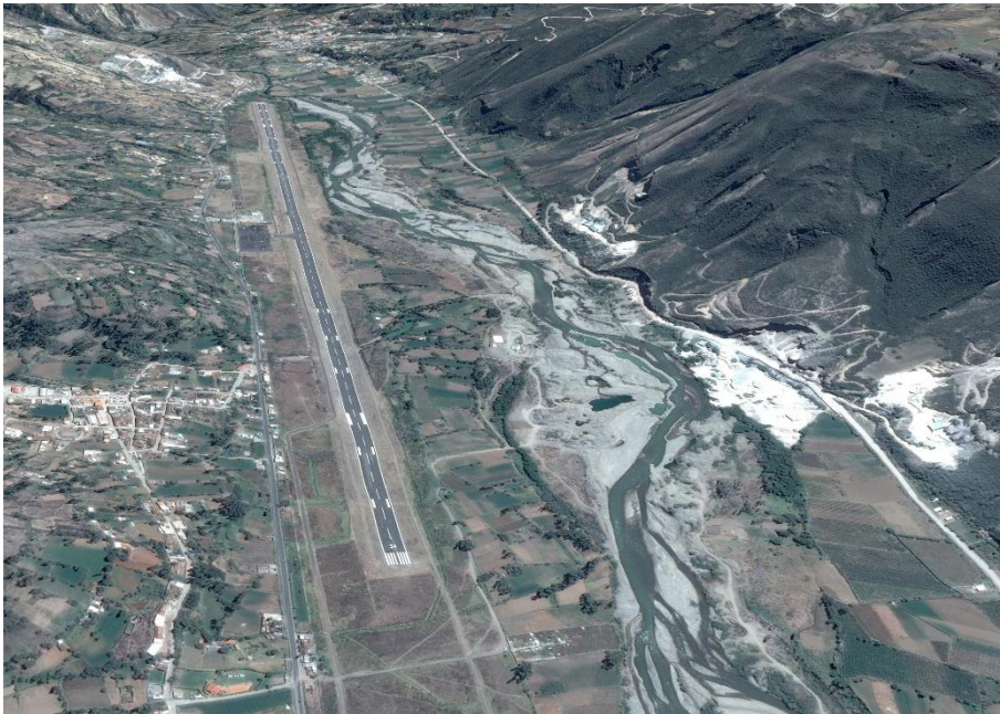
Figura 61 Vista 3 D de la pista del Aeropuerto Comandante FAP Germán Arias Graziani – Anta Fuente: Google Earth Pro, Imagen Pleyades, fecha de toma: 17 de junio de 2017
