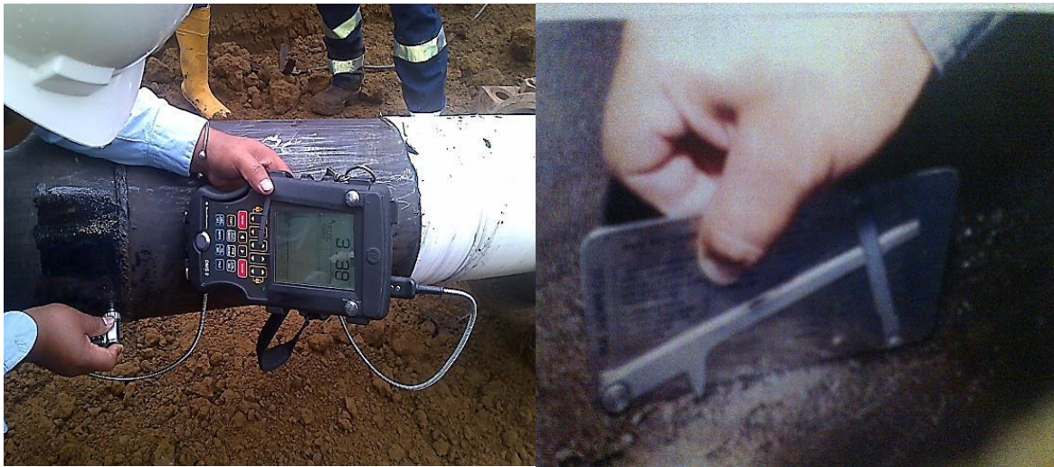
Foto 2.4 Monitoreo del control de integridad de ductos Fuente: Investigador
