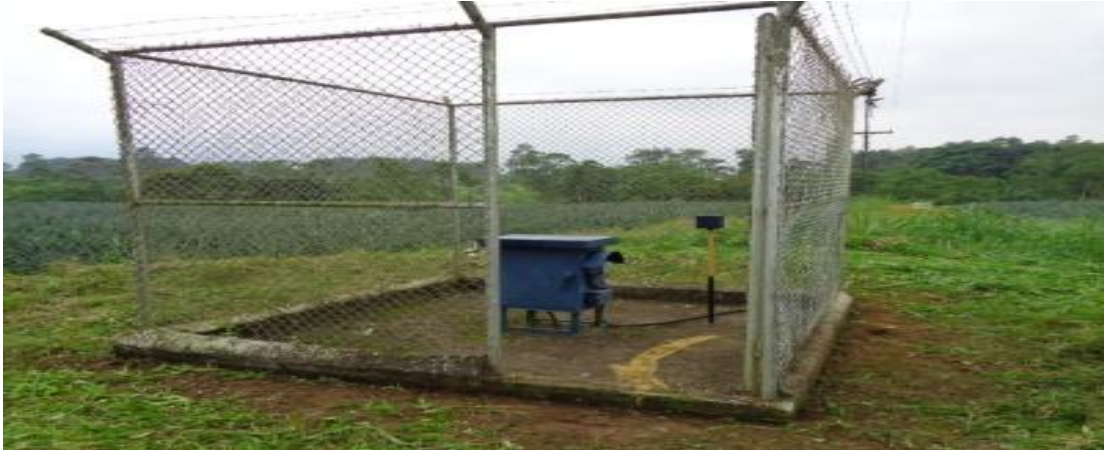
Foto 2.5 Derecho de vía y rectificador de corriente impresa para ductos Fuente: Petroecuador
