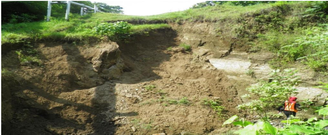
Foto 2.8. Deslizamiento y pérdida del derecho de vía
