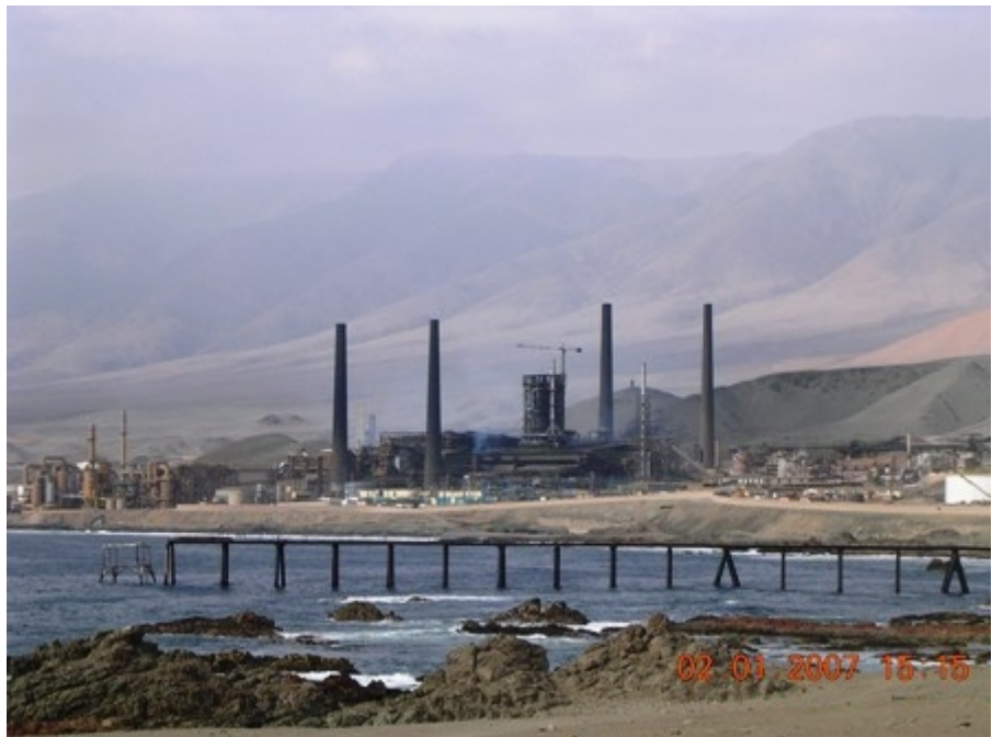
Vista panorámica de la Planta de Cementos norte Pacasmayo
