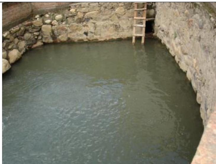
Figura 21: Pozo exterior de la Fuente termal de Chancos.
