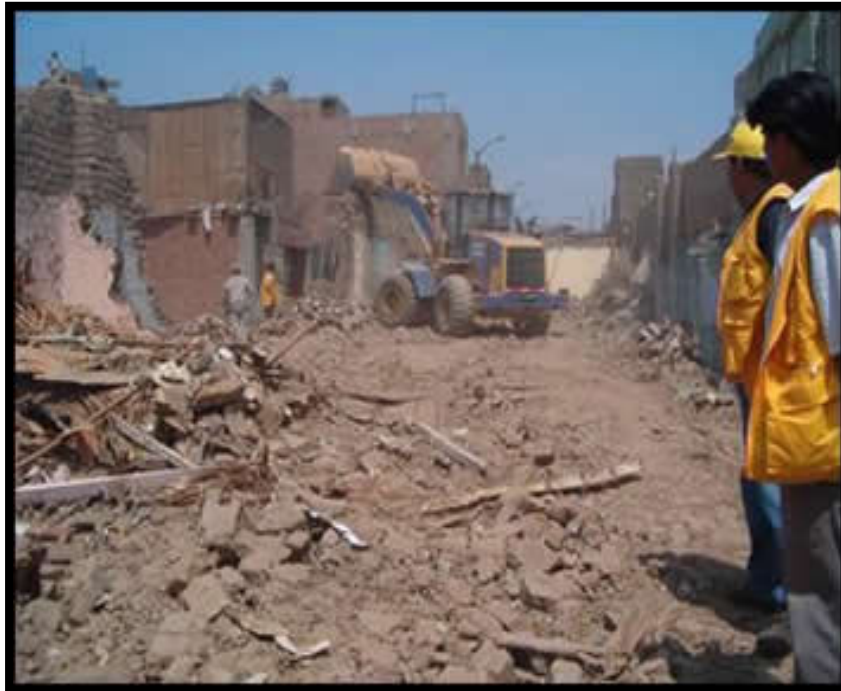
Remodelación urbana en el AA. HH. en su primera etapa: la demolición Fuente: http://www.munlima.gob.pe/
