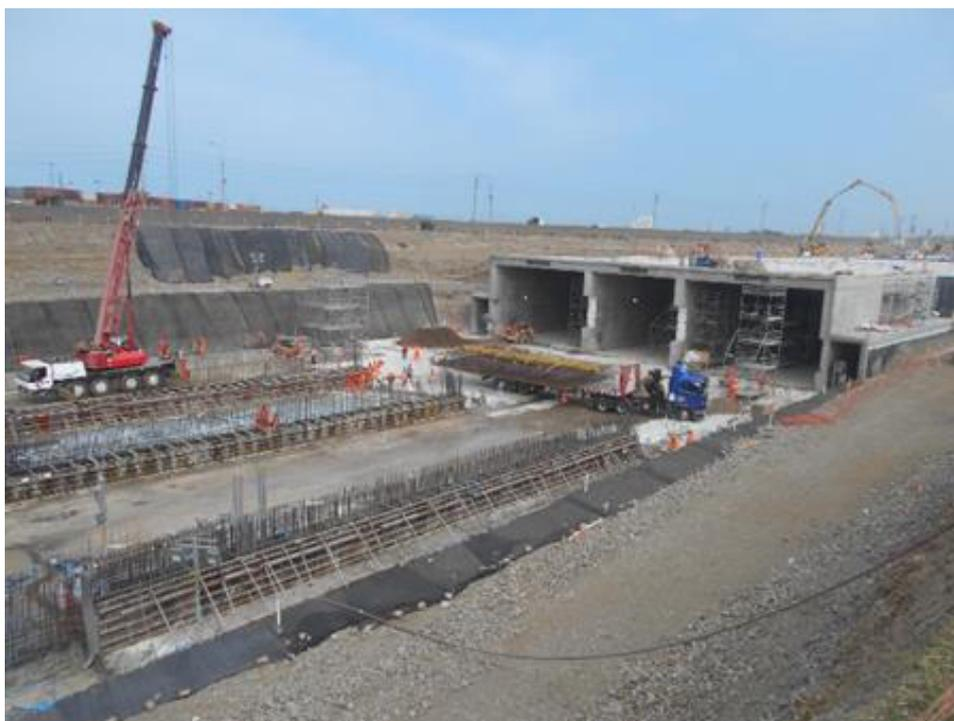
**Figura 4. Proceso constructivo de tres túneles (calzadas) y dos galerías de emergencia. Elaboración propia**
