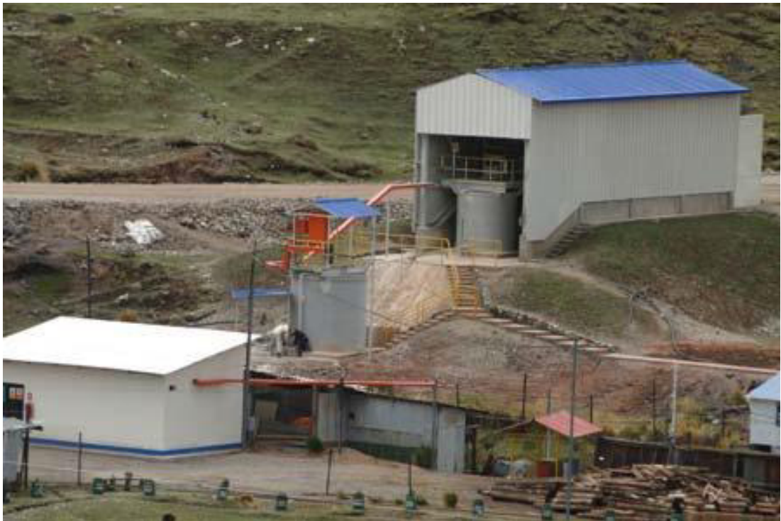
PLANTA DE ELABORACION DELECHADA DE CAL – SAN JOSE-HUARON
