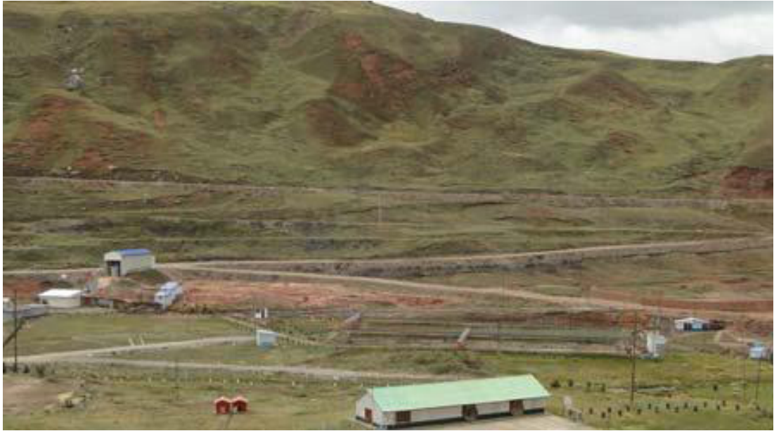
PLANTA DE TRATAMIENTO DE VERTIMIENTO DE AGUA DE MINA – SAN JOSE – NV 250 – MINA HUARON
