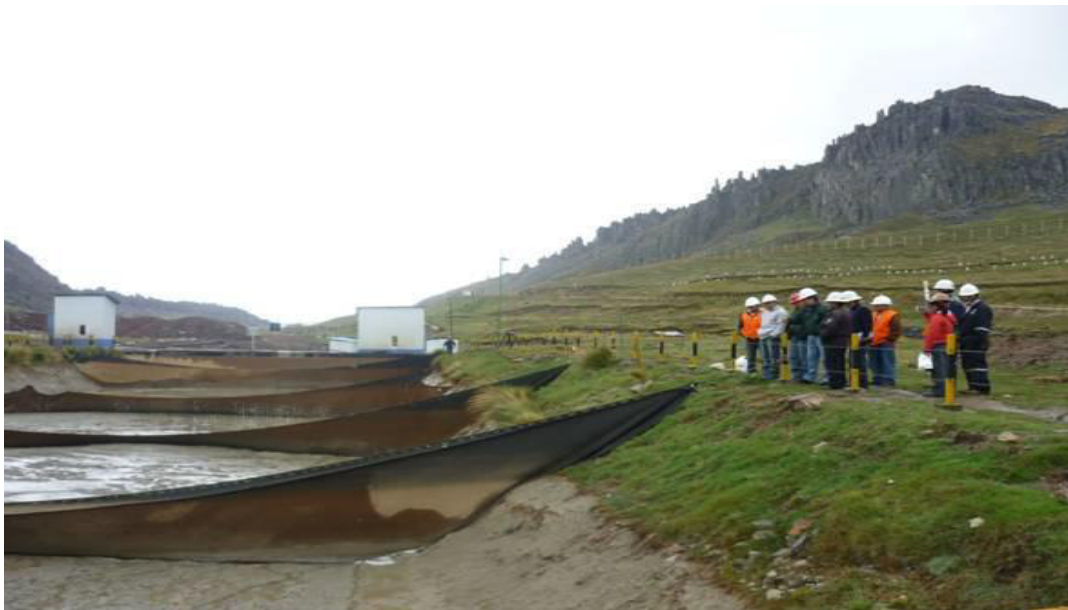
POZAS DE SEDIMENTACION DEL PROCESO DE TRATAMIENTO DE AGUA DE MINA – SAN JOSE - HUARON
