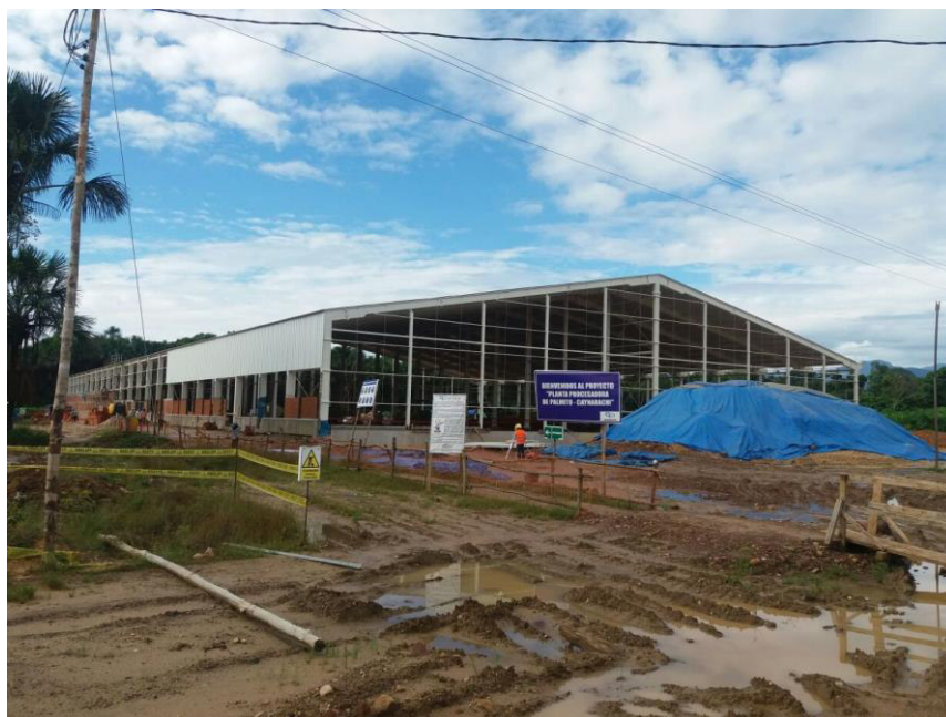
Figura 5. Nave Industrial del Proyecto Agroforestal de Pijuayo
