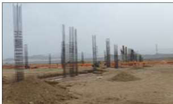
FIGURA N° 24 ARMADURA DE EJE 17 Y EJE 18
