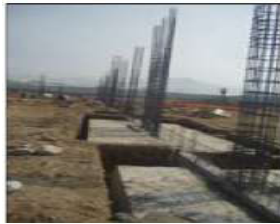
FIGURA N° 23 ZAPATAS DE LA NAVE
