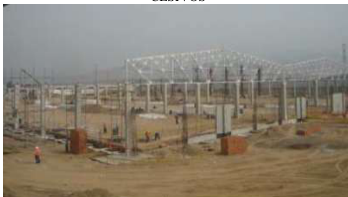
FIGURA N° 26 NAVE DE PRODUCCIÓN – MONTAJES SU- CESIVOS
