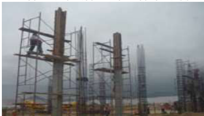
FIGURA N° 25 ENCOFRADO DE COLUMNAS S
