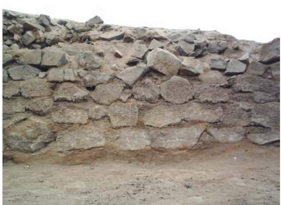
Foto 106. Detalle del Paramento Interno de la Plaza Circular (Muro 302).
