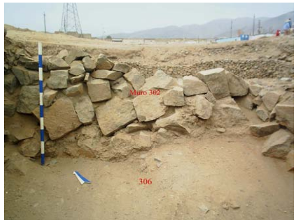
Foto 112. Detalle del Paramento Externo del Muro 302.
