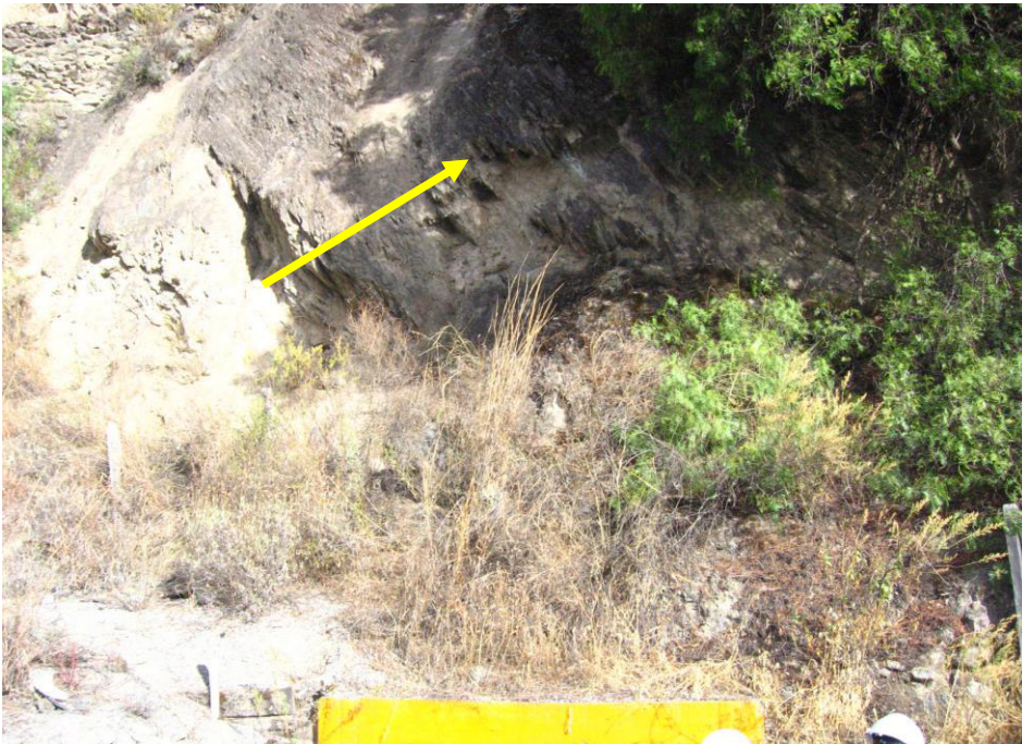
Foto N°2. Vista que muestra en detalle las características de la estación geomecánica
