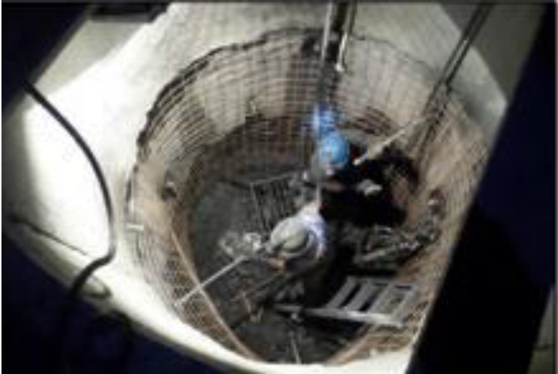
Figura 3.31. Vista del Pique 2, fase construcción, Fuente: Electroperú, (2014).
