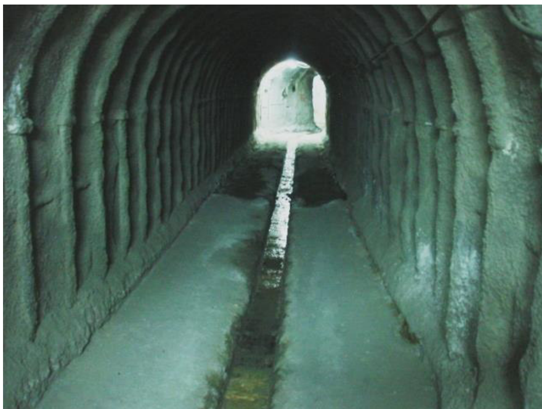
Figura 3.1. Vista del interior de la galería existente.
