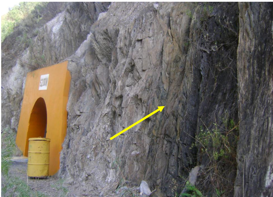
Foto N°2. Vista que muestra en detalle las características de la estación geomecánica
