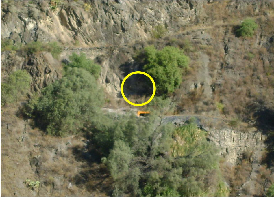
Foto N°1. Descripción. Vista panorámica que muestra la ubicación de la estación geomecánica.
