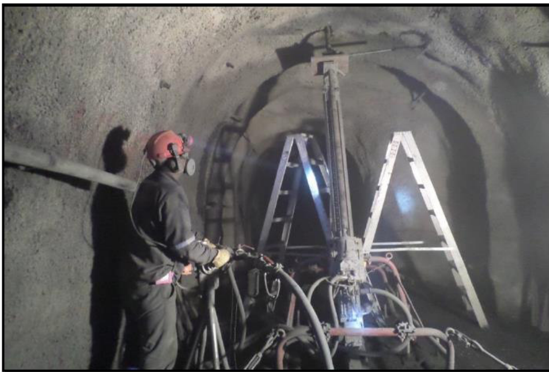
Figura 3.19. Vista de la construcción del nicho A, Fuente: Electroperú, (2014).
