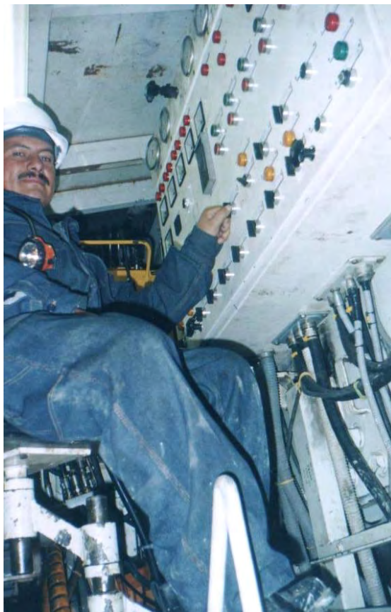
Fotog. N° 3-24: Consola del operador de la “TBM”
