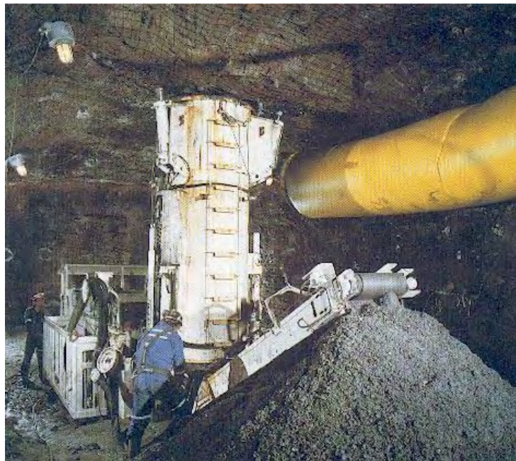
Fotografía N° 2-13: Borpak en proceso de excavación.
