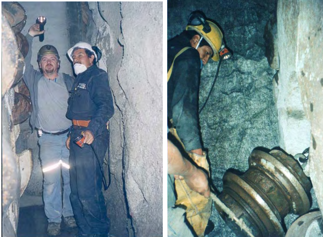
(a) (b) Fotografía N° 3-7: a) Inspección del cabezal antes de iniciar la excavación. b) Primer cambio de los cortadores centrales (mellizos).
