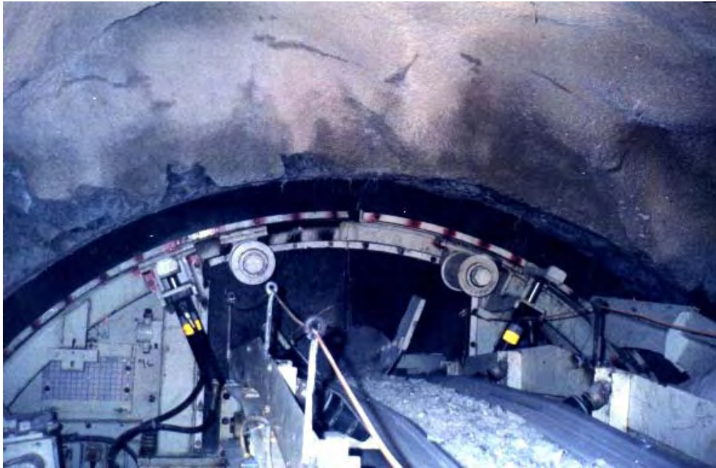
Fotografía 3-19: Escudo de polvo, mostrando además borde de Jebe, instalador de cimbras, tarjeta reticulada de alineación con laser y cordón de parada de emergencia.
