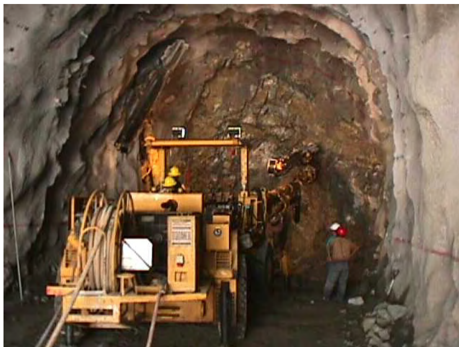
Fotografía N° 6-2: Jumbo hidráulico Rocket Boomer 282 perforando en el túnel de aducción N° 4 (ventana 3).
