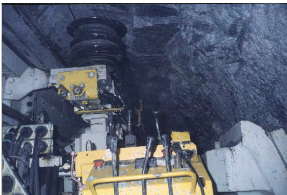
Fotografía N° 3-20: Jumbo hidráulico COP 1038 Atlas Copco, para sondajes delante de la TBM.
