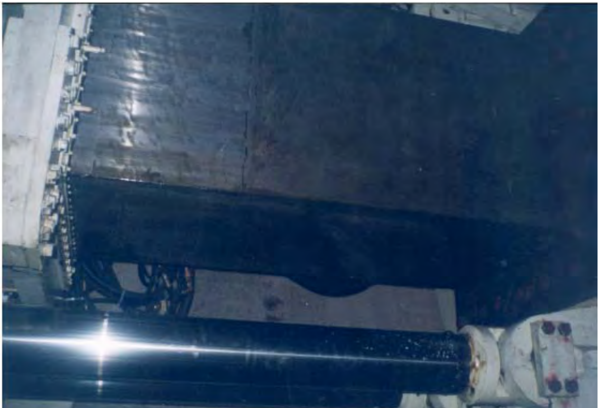
Fotografía N° 4-1: Pistones de empuje (thrust) inferiores en acción.
