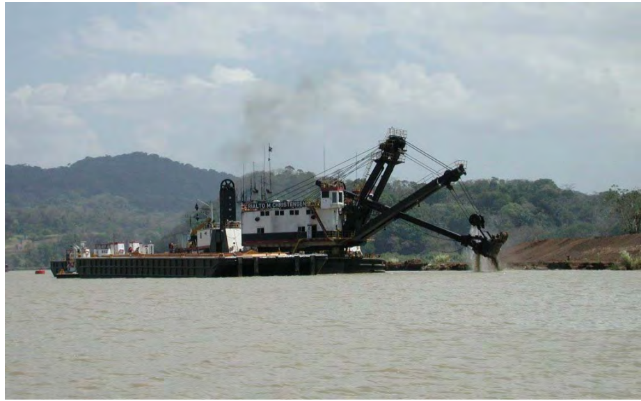
Fotografía N° 2-9: Draga con simple cangilón profundizando el Canal de Panamá.
