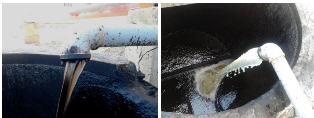
Fig. N° 64: Crudo Loreto antes y después de tratamiento químico con DMO46X Baker Hughes. Línea de drenaje del Tanque 11D-18, Terminal Bayovar, Petroperú.
