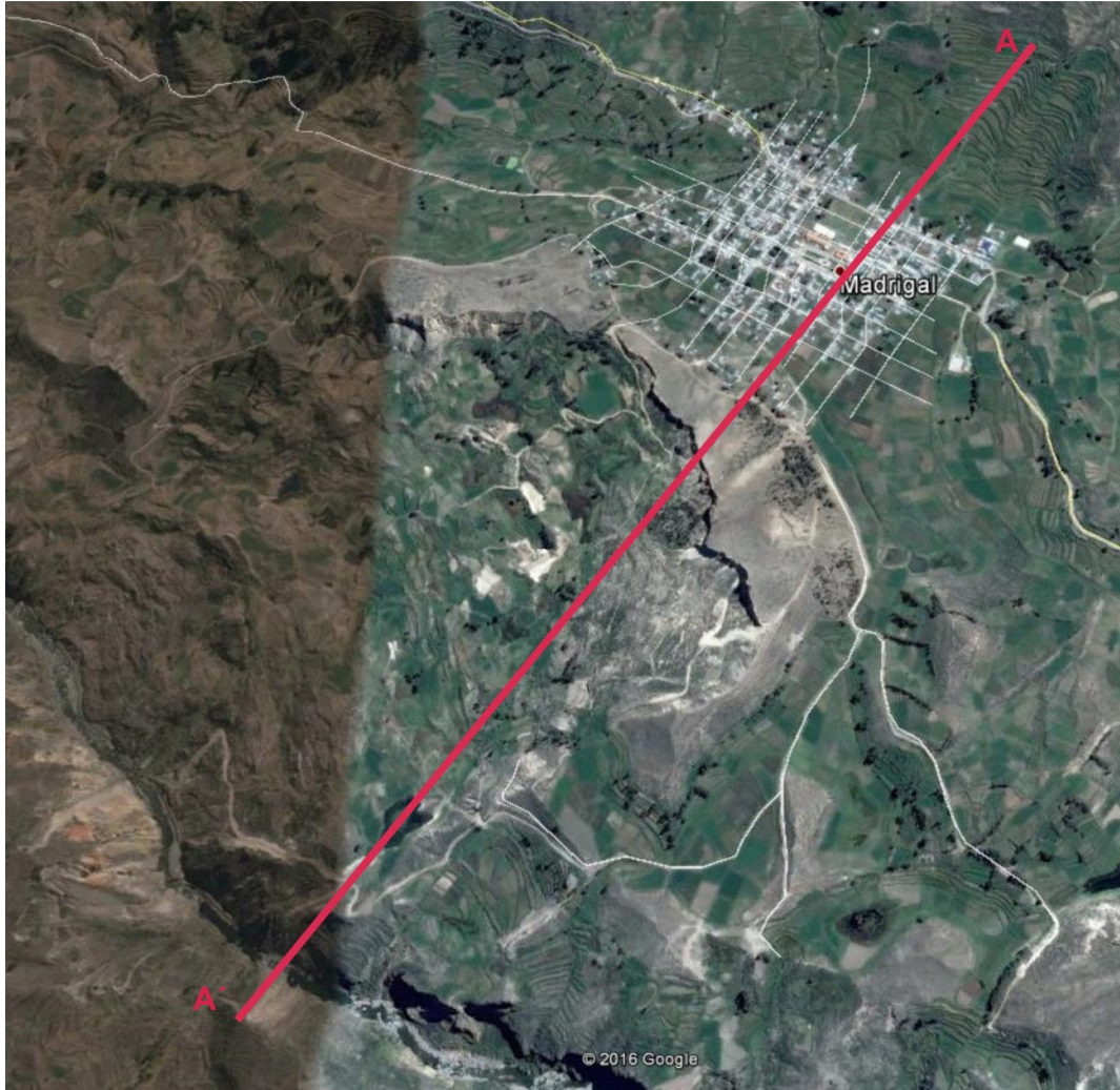
Figura 88. Vista de la sección A-A' que atraviesa perpendicularmente Madrigal y la zona de deslizamiento hasta el río Colca
