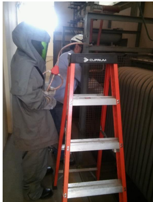
Colocación de puesta a tierra y en corto circuito
