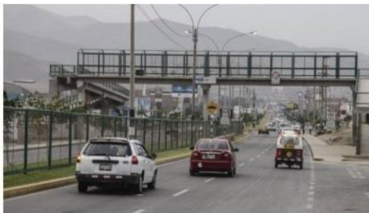
Callao: detectan 55 mlns. de pérdidas en obras en Av. Gambetta 18.10.2016 / 02:01 pm
