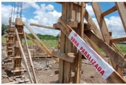
Perú registra 560 obras paralizadas por un valor de 1.350 millones de dólares
