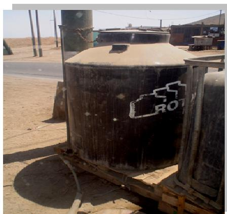
Foto 9 y 10: Asentamiento humano Virgen de la Mercede, nótese los tanques de agua conectados en los exteriores a fin de recolectar agua de camión cisterna para abastecer el domicilio. Fotografía: Julio Masías.
