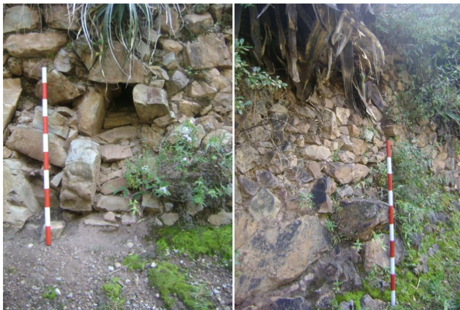
Fig. 70. Detalle de las andenerías Huarpa y Huari de Paras en la cuenca media del río Pampas, condicionadas con sistemas de drenajes y piedras salientes como escalinatas, las construcciones se inician en la ribera del río a 3100 msnm y llegan hasta las laderas superiores de los cerros sobre 4000 msnm.
