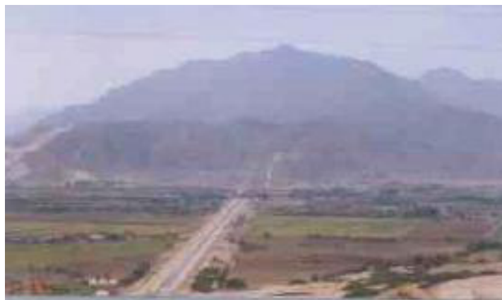
Fig. 2.10: Panorámica de Obras de Descarga del Canal Madre al Río Virú
