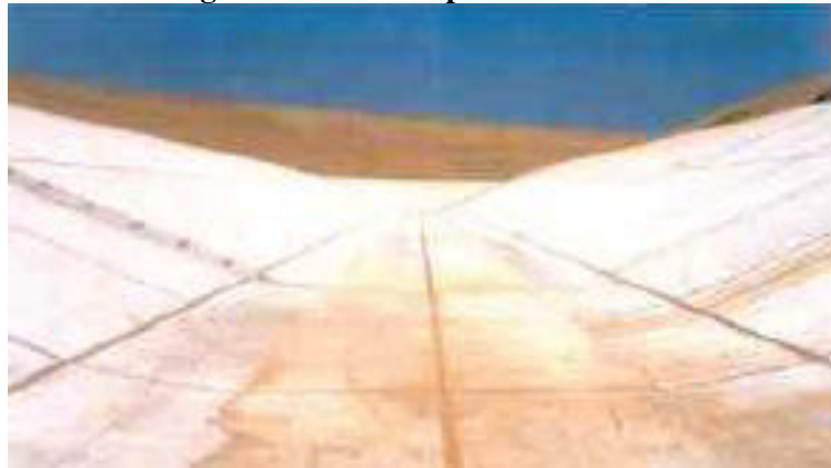
Fig. 2.6: Canal Pampa Blanca Lote 1
