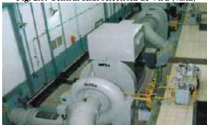
Fig. 2.8: Central Hidroeléctrica de Virú (vista)
