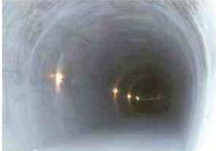
Fig 2.5: Túnel Intercuencas 10 km de Longitud
