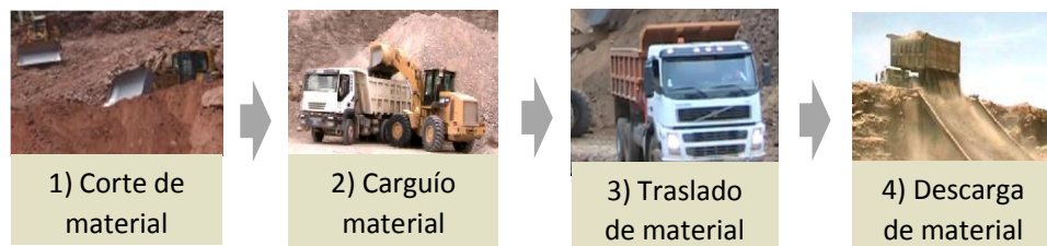
Figura 3. Proceso de extracción y traslado de material
