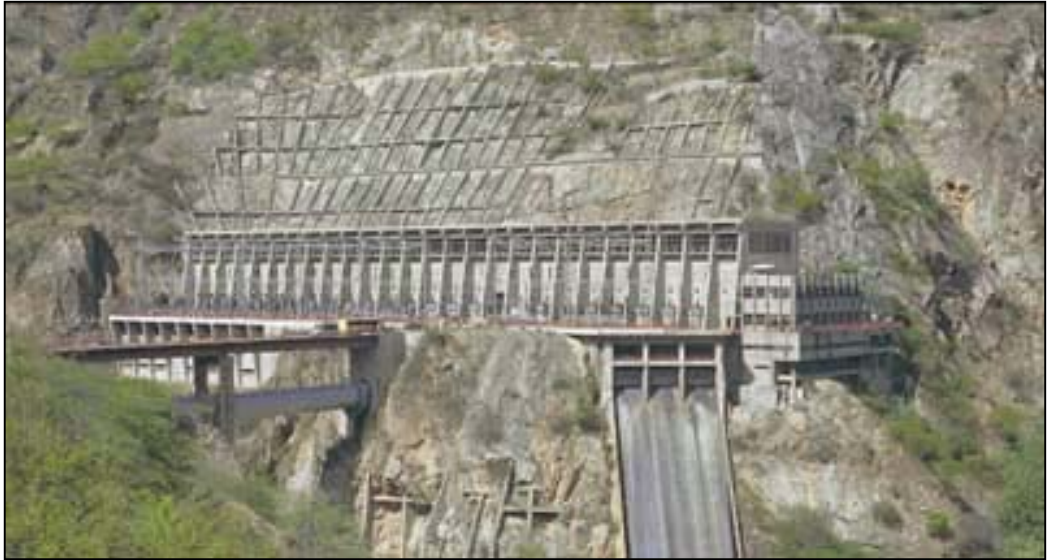
Fotografía N° 1.1 Central Hidroeléctrica Santiago Antunez de Mayolo (SAM)
