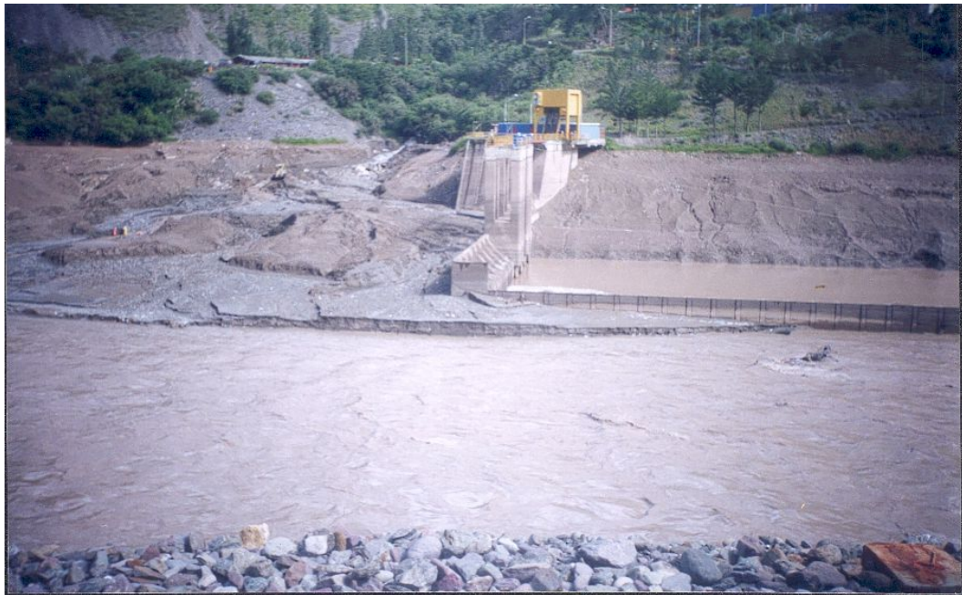
Fotografía N° 3.3 Presa Tablachaca Proceso de Purga 2001 - Nivel cota de embalse 2678 m.s.n.m.
