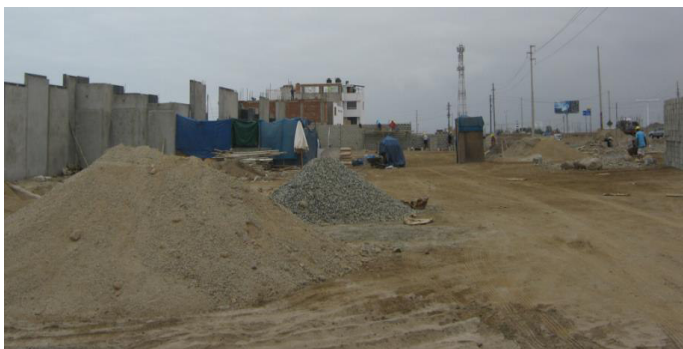
Fotografía 5.12 Vista de la construcción de la cochera para el Club Náutico en la Urb. Miramar (registro propio, noviembre -2012).
