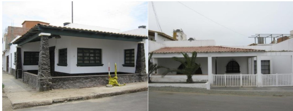
Fotografías 5.7 Viviendas con techos exteriores de madera y teja parte del diseño arquitectónico no estructural (registro propio, noviembre - 2012).
