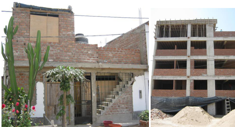
Fotografías 5.4 Al lado izquierdo una vivienda confinada, y al lado derecho una vivienda aporticada (registro propio, octubre -2012).
