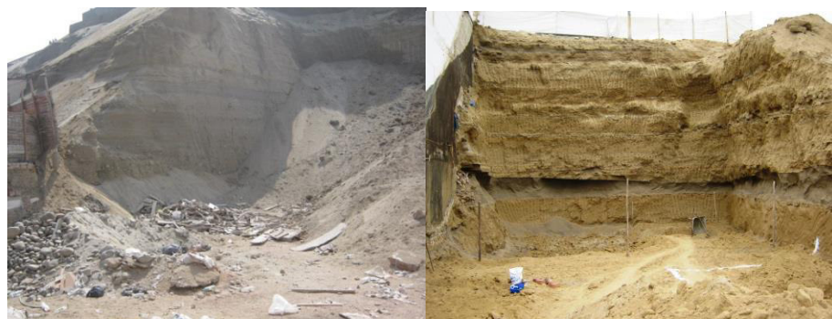
Fotografías 7.11 Corte del talud natural con fines constructivos (registro propio, noviembre -2012).
