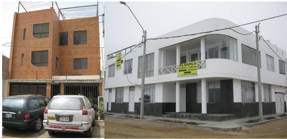
Fotografías 5.1 Vista de viviendas multifamiliares (registro propio, octubre - 2012).
