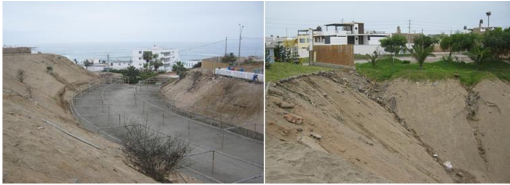
Fotografías 7.13 Obstrucción del cauce natural de la Quebrada seca que delimita la Urb. La Planicie y A.F. Santa Cruz (registro propio, octubre -2012).
