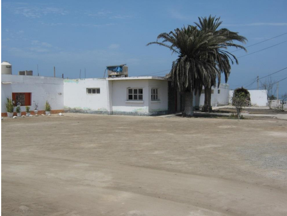
Vista de la comisaria abandonada después del sismo del año 2007
