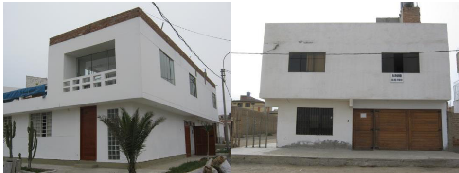
Fotografías 5.8 Vista de viviendas con volados o aleros (registro propio, noviembre -2012).
