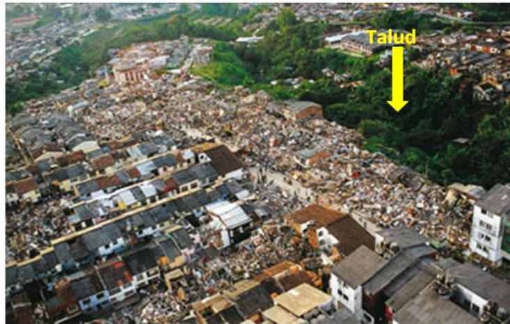
Fotografía 7.10 Efectos de la amplificación del sismo de Armenia en la cresta de taludes (caso Barrio Brasilia). Ingeominas, (1999) 12 .
