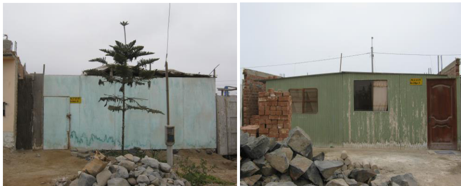
Fotografías 5.2 En el lado izquierdo vista de una vivienda improvisada de triplay y al lado derecho una vivienda en madera machimbrada (registro propio, febrero - 2012).
