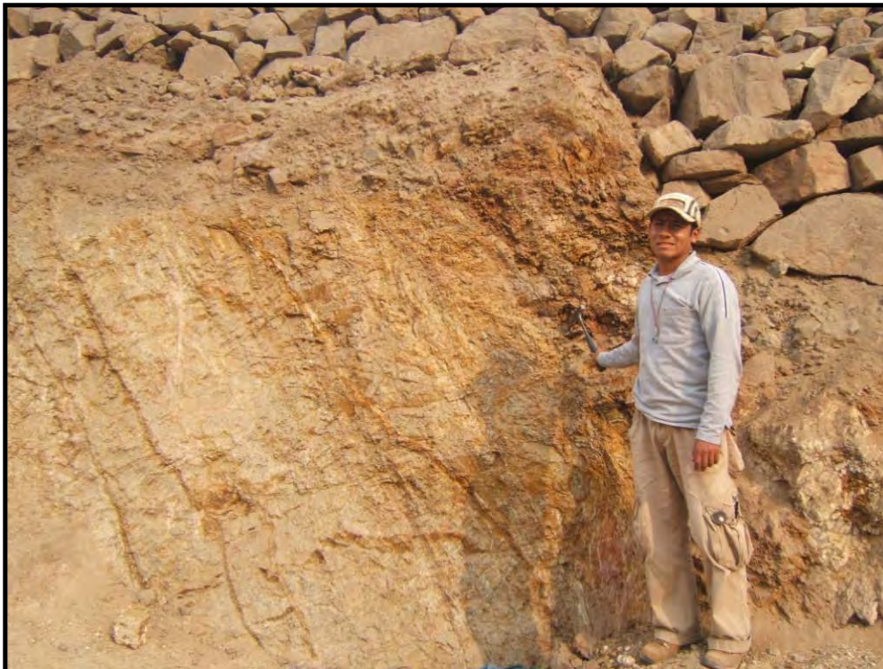
Foto N° 4.9 Zonas alteradas observadas en los cortes de talud, evidencia de actividad tectónica en la Qda. Canto Grande.
