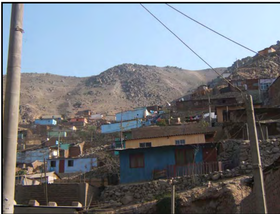
Foto N° 7. 13 AAHH Saúl Cantoral. Caída de Rocas con una zona de arranque irregular compuesta por bloques aislados subangulosos, dispuestos en una ladera con una pendiente de 40°
