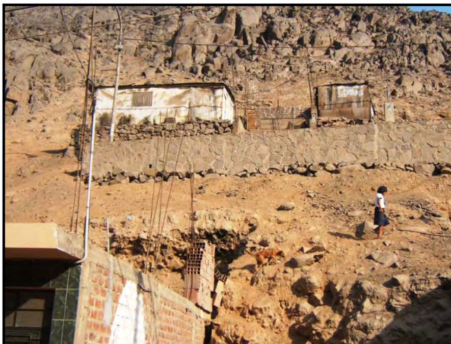
Foto N° 7. 14 AAHH Santa Rosa de Lima. Sector propenso a caída de bloques rocosos que se desprenden de un afloramiento meteorizado y diaclasado. Se observa un muro de contención que resulta insuficiente ante un desastre.
