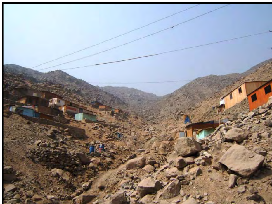
Foto N° 7. 10 Mariscal Cáceres / Las Vegas. Caída de Rocas: Bloques dispuestos en una ladera con un ángulo de inclinación mayor a los 30°; poseen una zona de arranque irregular. Las viviendas están ubicadas sobre pircas inestables. De producirse un sismo de gran magnitud más de 50 viviendas serían afectadas.
