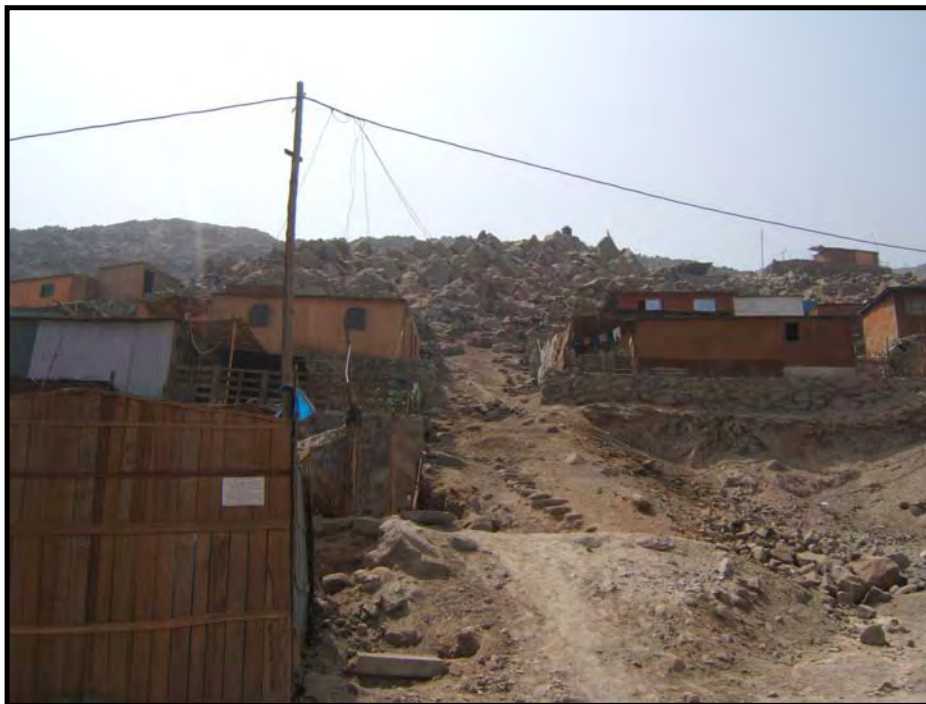
Foto N° 7. 9 AA.HHs. Unidos al Desarrollo. Zona propensa a Caída de Rocas, ante un sismo los bloques pueden desprenderse del afloramiento rocoso afectando a las viviendas
