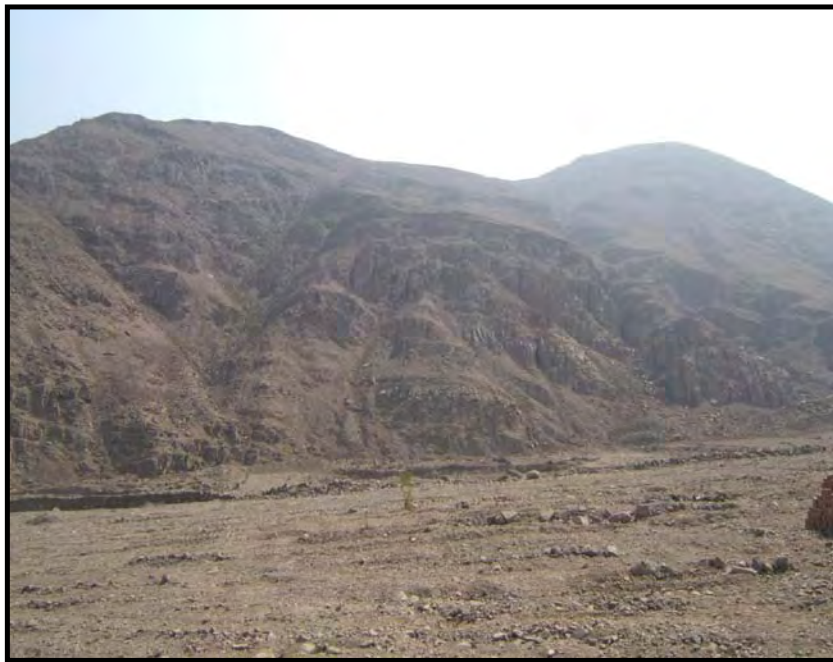
Foto N° 7. 6 Sector Nuevo Amanecer. Zona propensa a Caída de Rocas y Derrumbes debido a la construcción inadecuada de "pircas"
