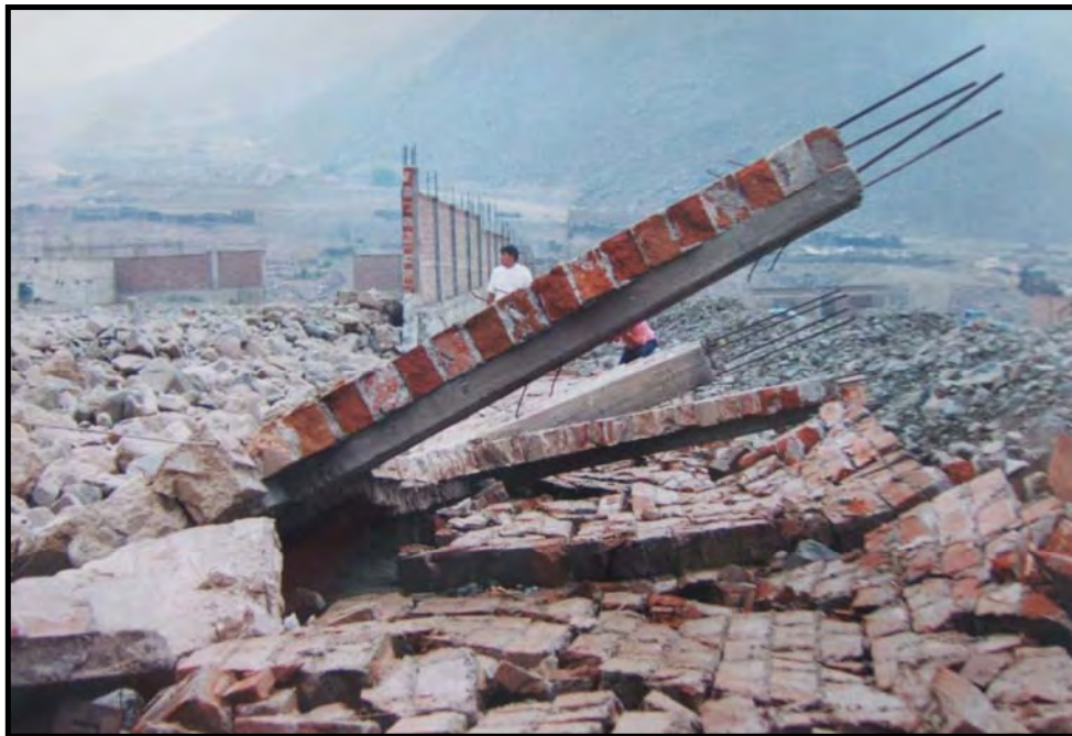
Foto N° 5.3 Paredes colapsadas por la colisión de los bloques que trajo el flujo.en el año 2003 (Fuente. Comunidad Campesina Jicamarca Anexo 22)
