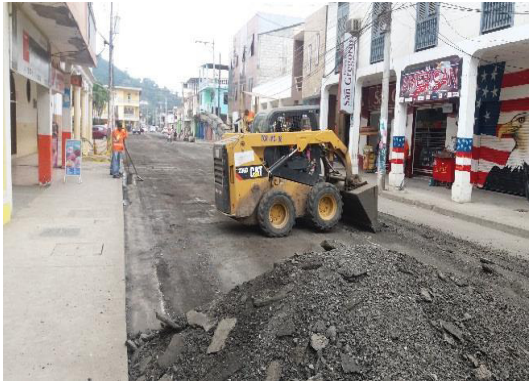
Acopio de pavimento asfáltico envejecido para posterior desalojo
