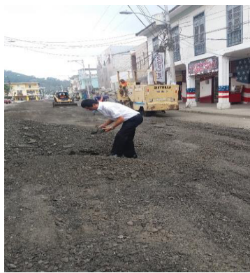
Inspección de los reciclados de pavimento asfáltico envejecido
