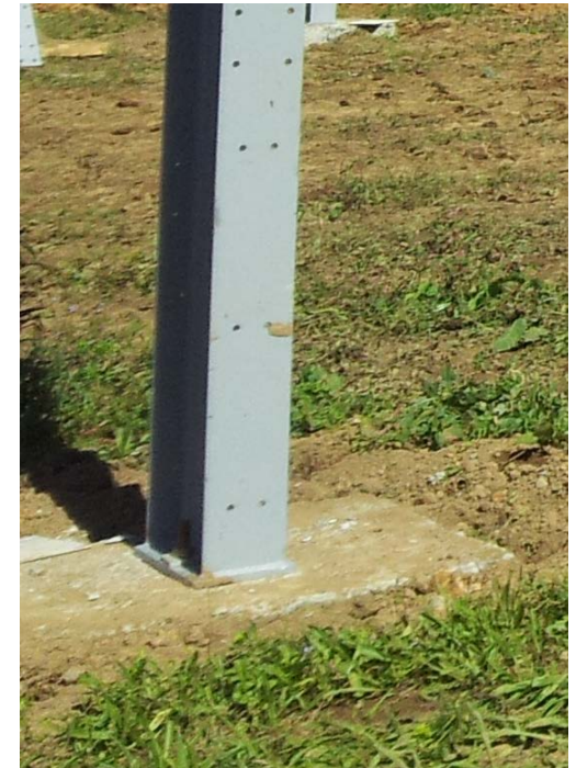
Zapata de hormigón
