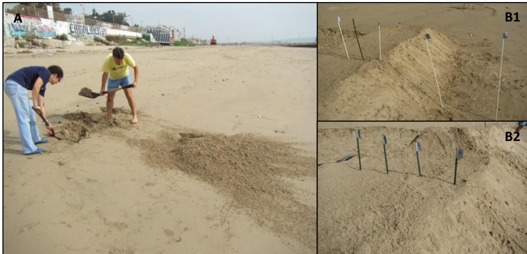
Figura II. 15 – Construção das dunas; B – Dunas com as respectivas estacas: B1 –duna 1; B2 – duna 2.
