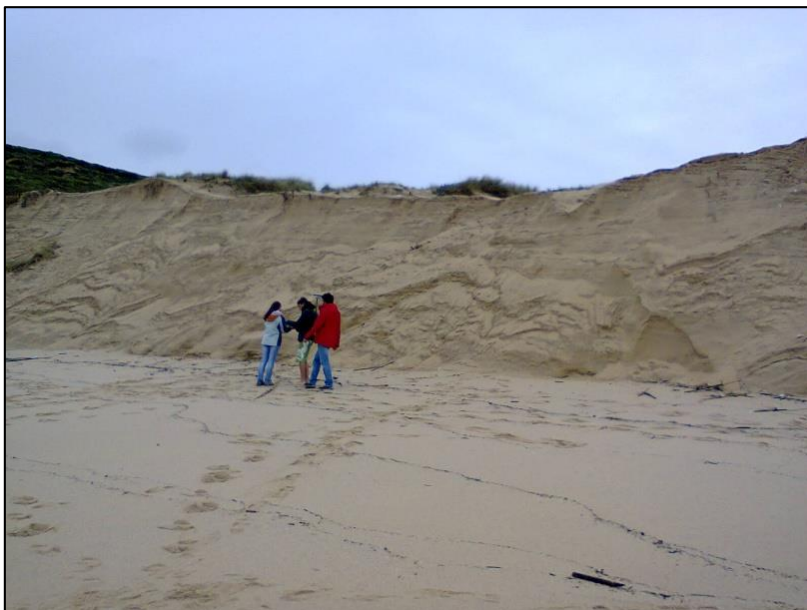
Figura III. 5 – Escarpa de erosão da praia da Foz do Lizandro.
