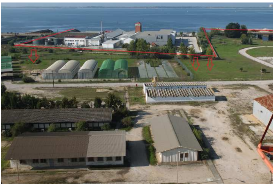
Fig. 39 - Frente Sul da Central Termoelétrica de Setúbal
