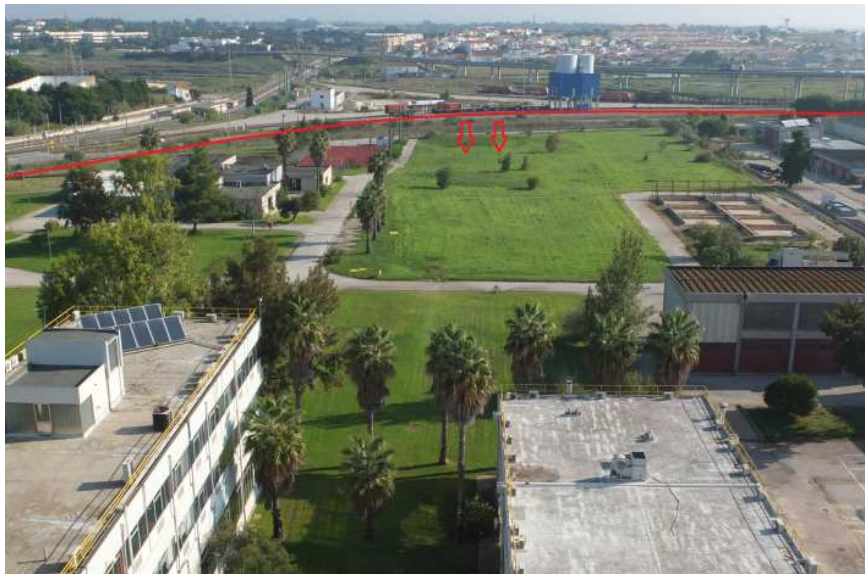
Fig. 38 - Frente Norte pertencente à Central Termoelétrica de Setúbal
