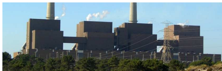
Fig. 19 - Vista frontal dos GGV de tipologia interior da Central Termoelétrica de Sines
