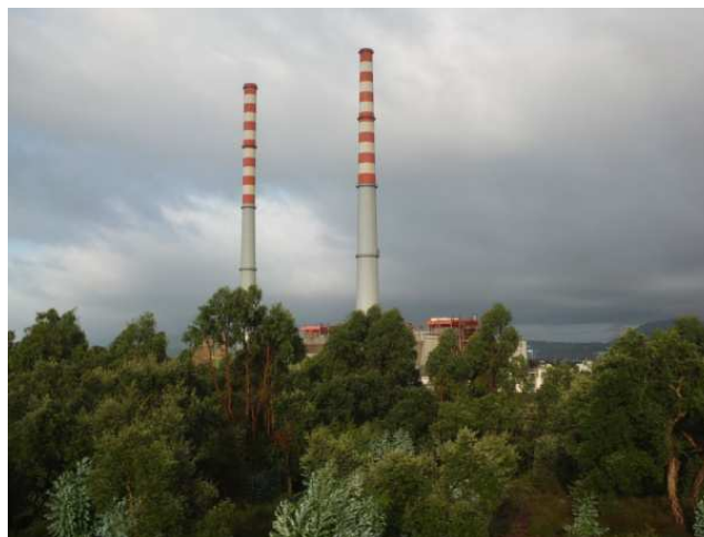
Fig. 33 - Chaminés da Central Termoeletrica de Setúbal (cortesia Júlio Matos, 2011)
