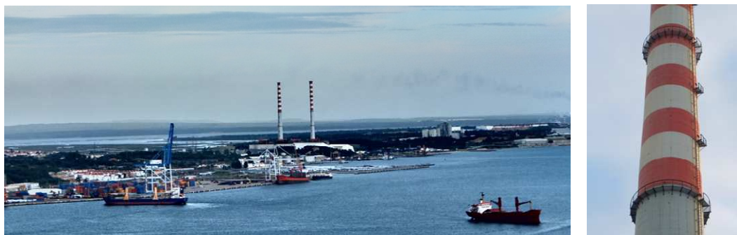
Fig. 21 - (a) Vista das chaminés da Central de Setúbal a partir do Forte de S. Filipe na Arrábida. Outubro 2014 (b) Parte de uma chaminé da Central de Setúbal.
