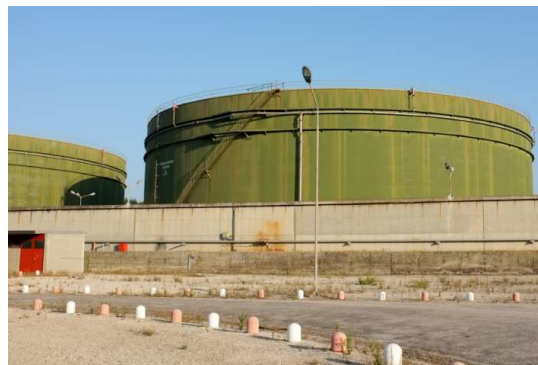
Fig. 36 - Parte do parque de armazenamento da Central Termoelétrica de Setúbal
