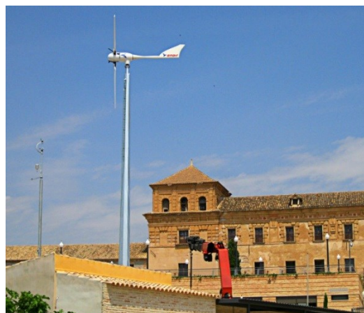
Figura 5 - HAWT da marca Enair situada na Universidade Católica de Murcia, retirado de: http://www.enair.es/instalaciones/instalacion/universidad-cat-murcia
