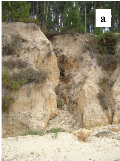
Figura 51 – Associação entre ravinamento e desníveis topográficos, frequentemente resultantes de aterros/desaterros nas bermas de estradas e caminhos. (a) Ravina de desnível no desaterro entre uma extensão de eucaliptal e uma estrada. (b) Cabeceira em regressão e bifurcação após o seu surgimento no desaterro entre um olival e a estrada nacional. Ambas as formas se situam na freguesia de Ulme, Chamusca.
