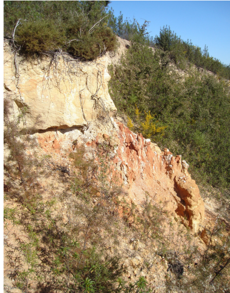
Figura 119 - Padrão mesclado de manchas avermelhadas e esbranquiçadas, indicando drenagem reduzida e interpretado como sugerindo um elevado teor em argila. Forma F25, na margem direita da ribeira de Ulme.
