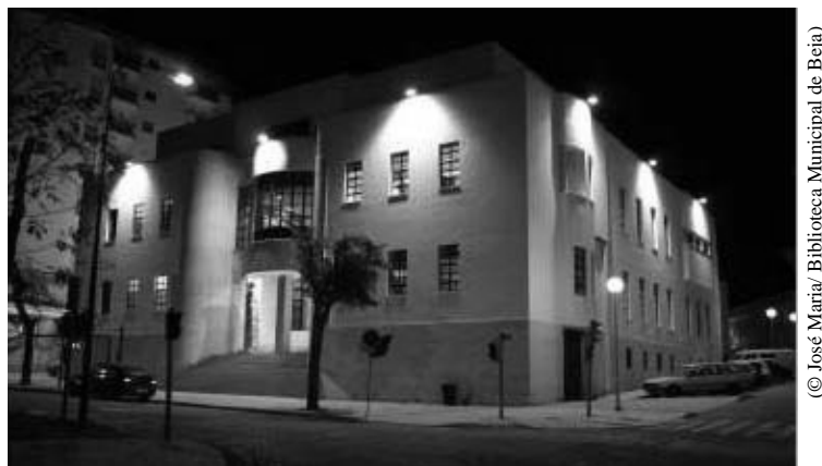
Imagem 1 – Vista noturna da fachada e alçado lateral direito da Biblioteca Municipal José Saramago
