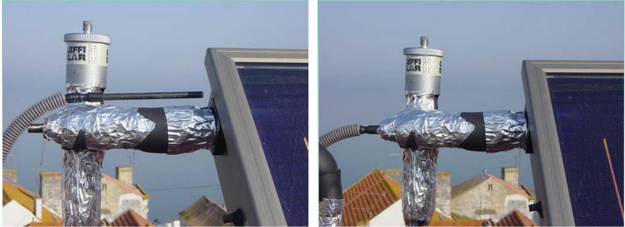
Figura 5 - Colocação correta das sondas de temperatura (fonte: apresentação PowerPoint da disciplina de Energia Solar Térmica ano letivo 2012/13)
