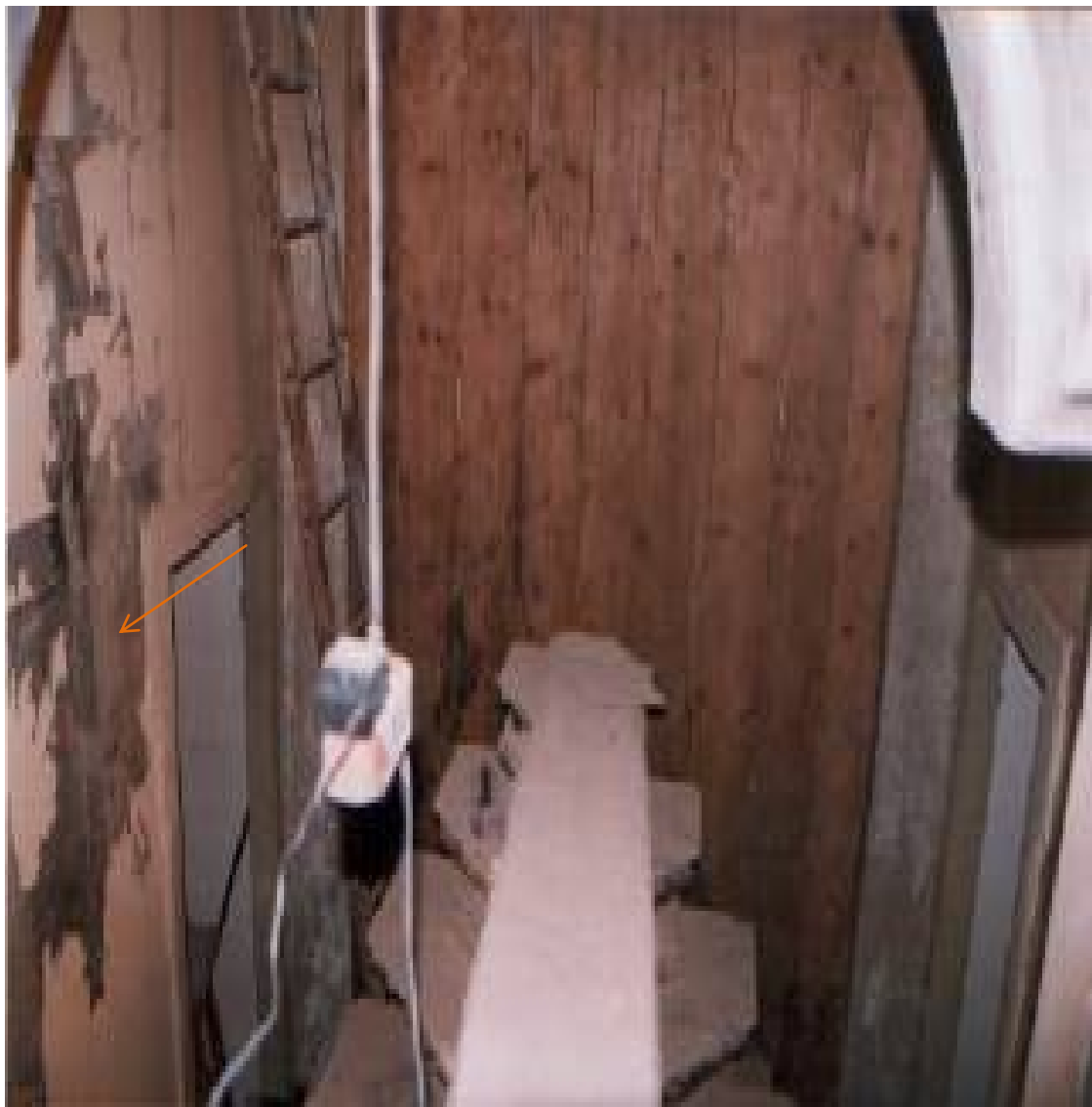
Figura 4. Descoberta da pintura “Visitação”, de Thomás Luis, no forro lenhoso da tribuna do retábulo setecentista. Primeira fase da intervenção de 1998- remoção da camada branca existente sobre a pintura escondida.
