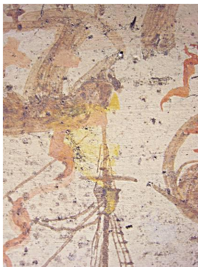
Fig. 29 – Pintura mural do Salão das Armas : observou-se lacunas na camada pictórica e marcas de lixiviação. © Filipa R. Cordeiro.
