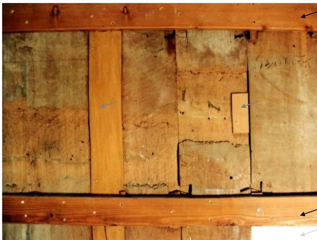
Fig. 284 – Tratamento do suporte (1998) - travessas de reforço (setas pretas); contraplacados (setas cinzentas); zonas não colmatadas (seta cinzenta clara). © F. R. Cordeiro.
