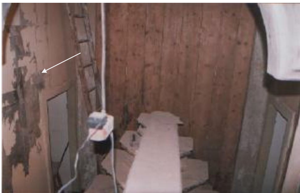
Fig. 276 – Forro da tribuna do retábulo setecentista. Descoberta da Visitação de Thomas Luis em 1998. 1ª fase da intervenção - remoção da camada monocromática branca que cobria a pintura. © SCMM.
