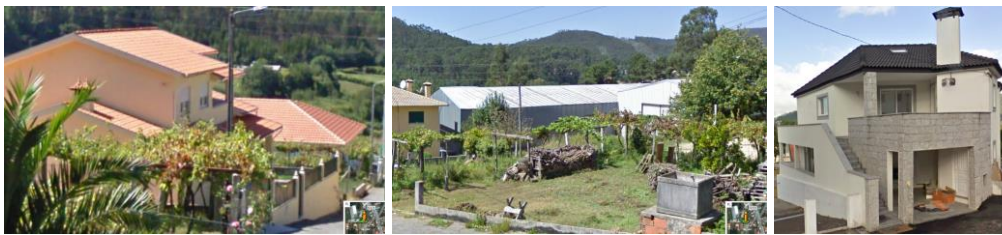
Figura 34 – Exemplos de Área Social com Telha de Cerâmica; Telha Branca ou Metalizada e Telha Escura Fonte: [Google Earth 3D, 2014]
