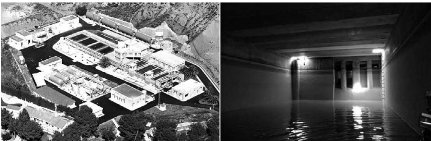
Figura 25. Izq.: vista aérea de la ETAP de Lorca, en el barrio de Los Ángeles; dcha.: imagen del interior del Depósito de Reserva de Lorca (Fuente: MCT).
