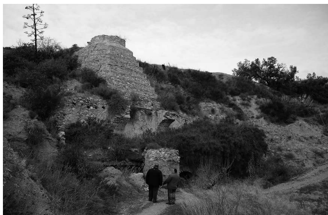
Figura 6. Molino hidráulico de cubo en el sistema de La Asunción o del Cabezo. (Fuente: GÓMEZ, J. M a . 21-12-2007).
