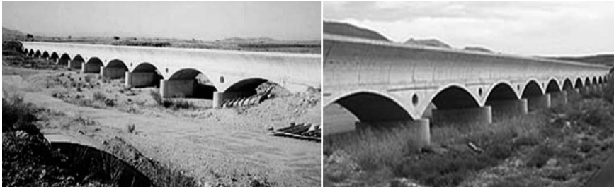
Figura 21. Imágenes del acueducto de las Norias (Fuente: izq.: CHS; dcha.: SCRATS).
