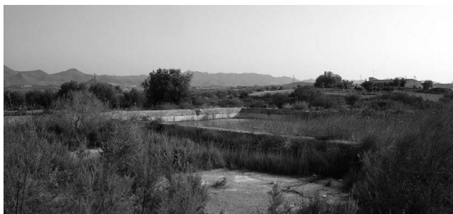
Figura 1. Balsa en la que se acumulan las aguas del qanat “Virgen de Los Desamparados” en el paraje de Gacia (Huércal-Overa). (Fuente: GÓMEZ, J. M a . 30-07-2012).
