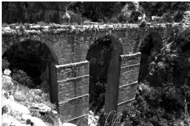
Figura 16. Acueducto de la Peña Cortada (Chelva).
