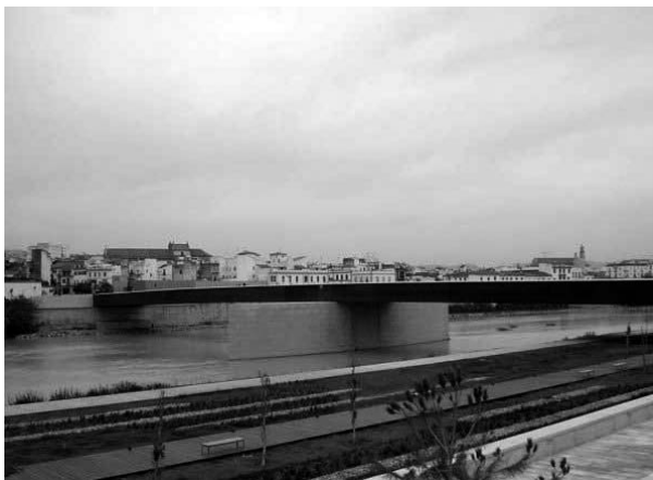
Figura 1. Puente de Miraflores. Fuente: A. Mulero
