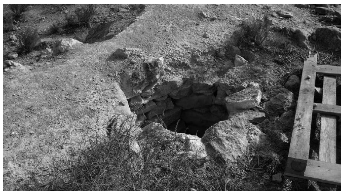
Figura 3. Boca de la cuarta lumbrera en el qanat "Virgen de Los Desamparados". (Fuente: GÓMEZ, J.M a . 30-07-2012).
