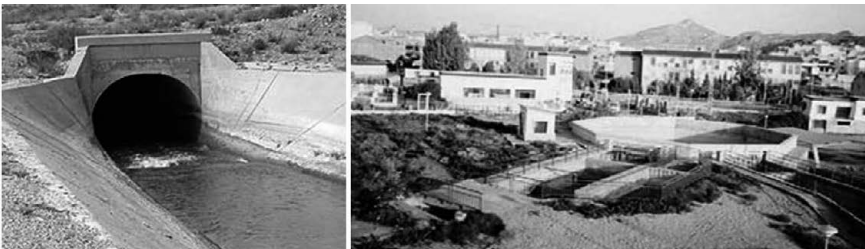
Figura 20. Izq.: Túnel de Carraclaca (Fuente: SCRATS); dcha.: Partidor de Lorca (Fuente: CHS).
