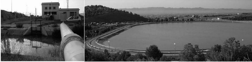
Figura 24. Izq.: estación de impulsión de Lorca, en la margen izquierda del Canal Principal de la Margen Derecha del Postrasvase Tajo-Segura (en primer término), y tubería de impulsión hacia el Balsón de Seguridad; dcha.: vista general del Balsón de Seguridad, con la ciudad de Lorca al fondo (Fuente: Luis F. Pulgarín).
