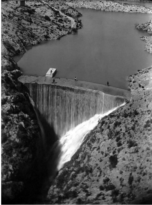
Figura 2. La presa de Rellu a finales del siglo XIX, cuando todavía estaba en funcionamiento. Obsérvese la ménsula triangular encajada en la cerrada. Hoy los sedimentos se encuentran a unos tres metros de la culminación del paramento aguas arriba. Fotografía de Leopoldo Soler y Pérez. Arxiu Municipal de la Vila Joiosa.
