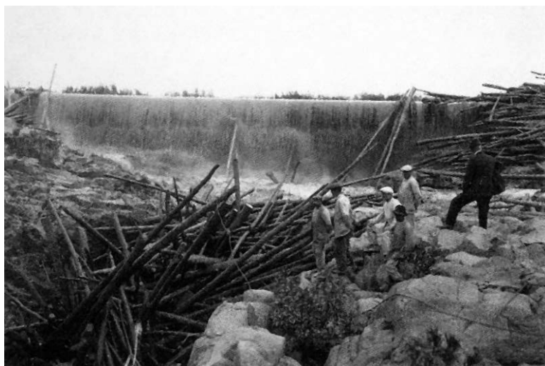
Figura 1. Efectos de una avenida en la presa de los Escuderos. 1917. Archivo de la Fundación Endesa.
