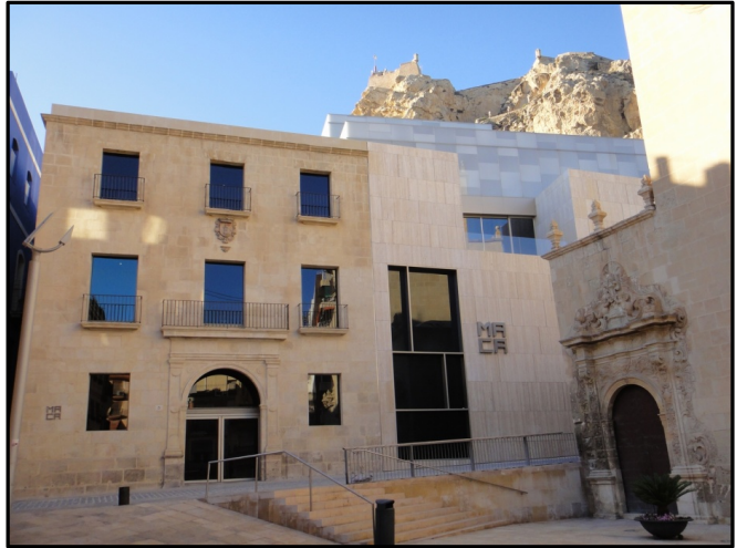
Fig.41. Edifici de l'Asegurada.
