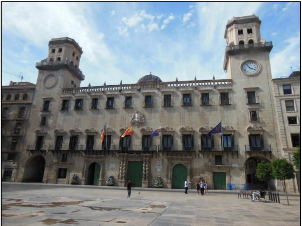
Fig. 34. Plaza y fachada del Ayuntamiento.
