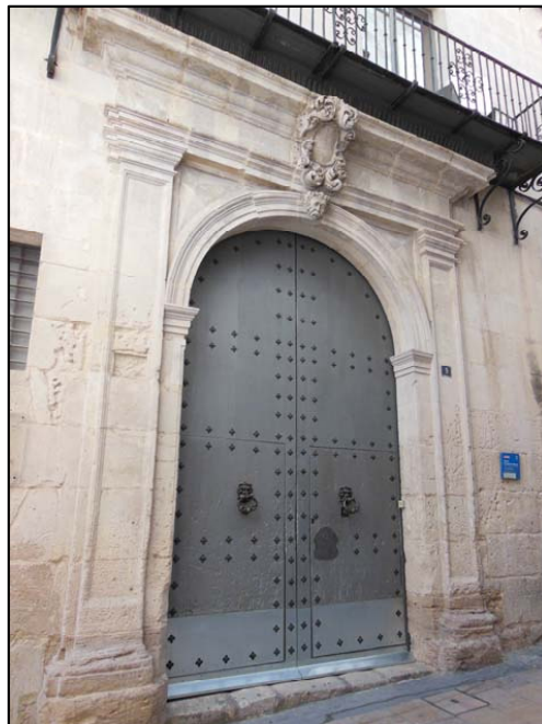
Fig. 26. Portal de sillería en la calle Labradores
