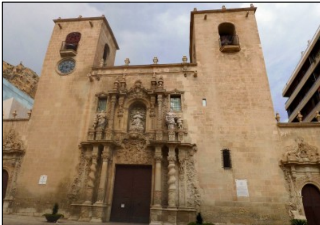
Fig. 39. Fachada de la Iglesia de Santa María.
