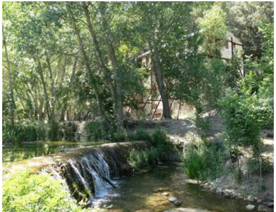
Figure 1 : Azud y Molí l’Ombria. Bañeres (Alicante, Spain).
