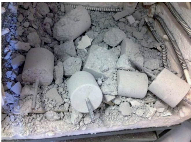
Fig. 1: Explosive spalling en una campaña experimental previa al presente estudio
