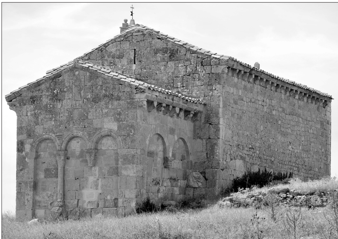
Figura 2. Ábside oriental y fachada septentrional de la ermita, desde el nordeste.
