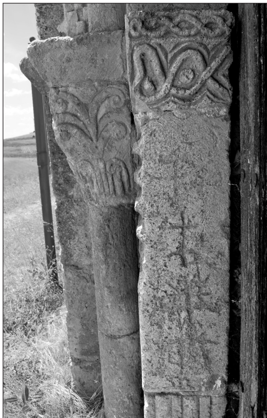
Figura 26. Jamba izquierda. Elemento nº 13. Vista de la sección.
