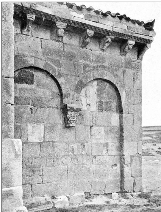
Figura 7. Fachada meridional del ábside, según Whitehill 1932: lámina X.
