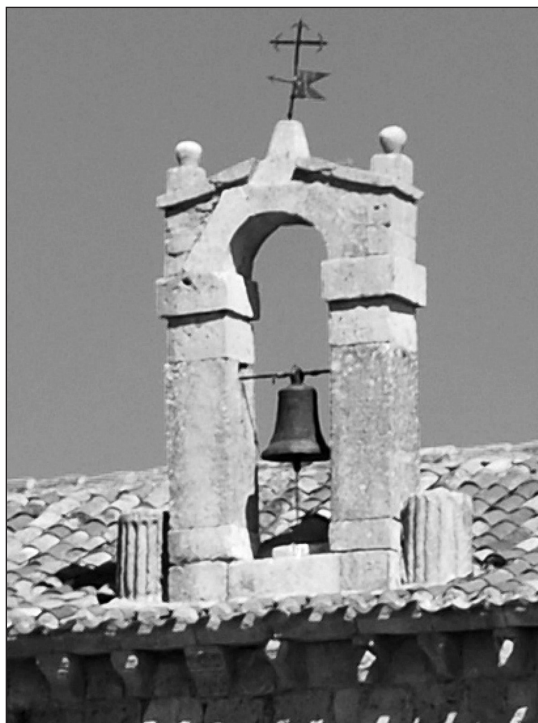
Figura 33. Fachada meridional. Elementos n.º 19 y 20.
