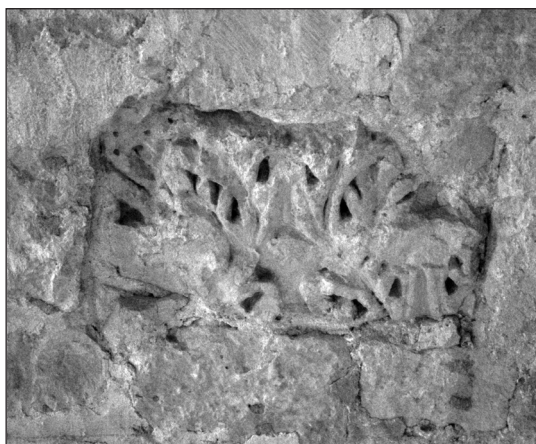
Figura 36. Interior de la nave. Elemento n.º 22.
