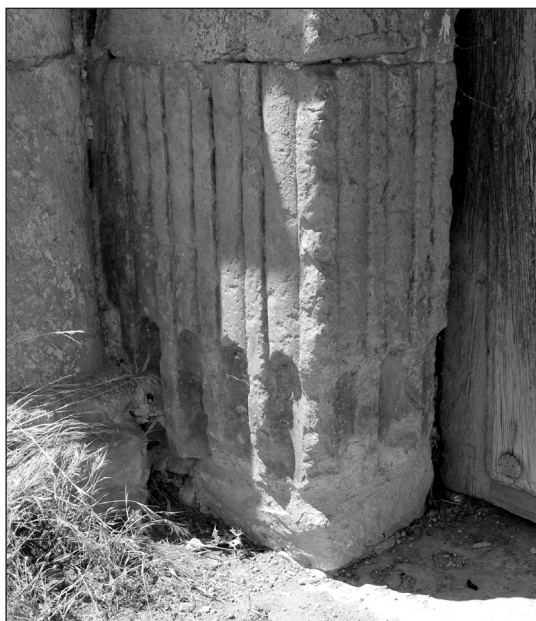
Figura 24. Jamba izquierda. Elemento n.º 12.
