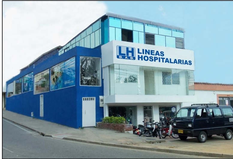
Figura 1: Sede Principal Líneas Hospitalarias
