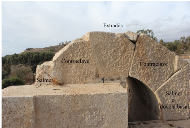
Figura 5: Vista de la bóveda del monumento. Denominación de las partes que la componen.
