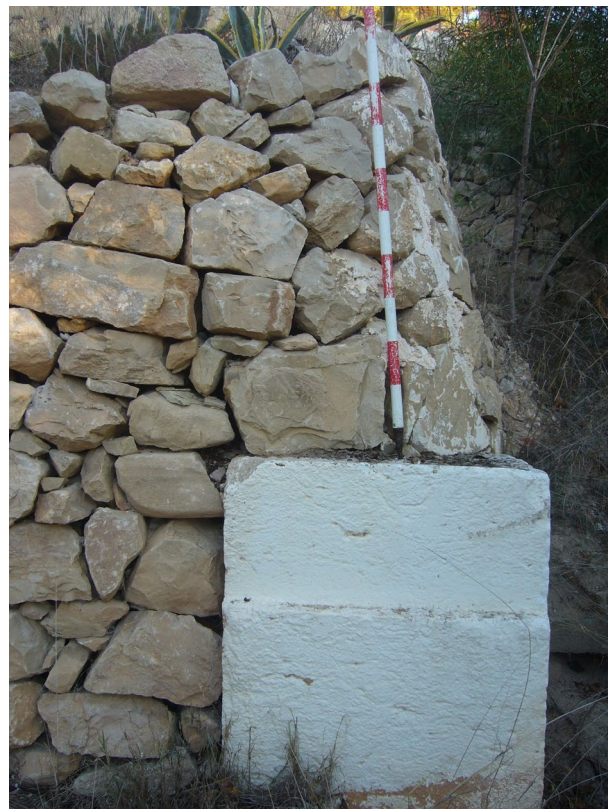
Figura 4: Vista del sillar TSJ 18 incrustado en uno de los márgenes de aterrazamiento de época contemporánea, situado a pocos metros al sur del monumento.
