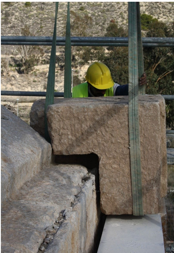
Figura 11: Momento de reubicación y ajuste del sillar TSJ 18. Vista desde el oeste.
