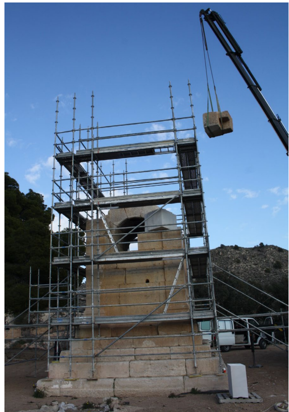
Figura 10: Proceso de reubicación del sillar TSJ 18.
