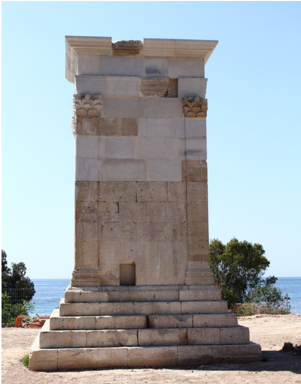
Figura 23: Vista de la Torre restaurada desde el norte. Mayo de 2015.
