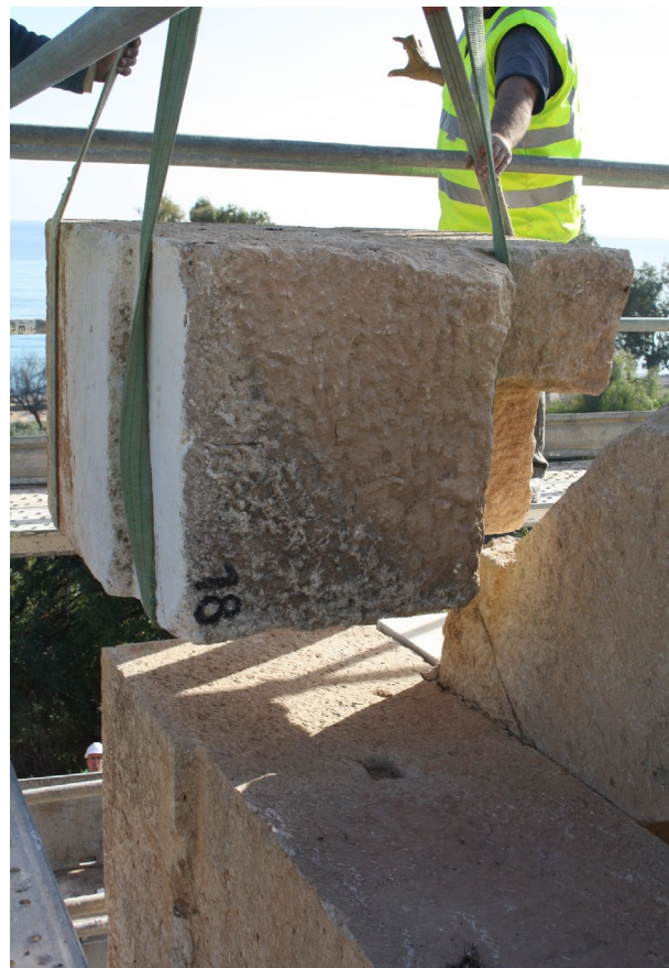
Figura 12: Reubicación y ajuste del sillar TSJ 18. Vista desde el norte.
